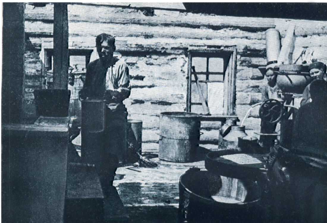
Общий вид старого кустарного маслодельного завода в с. Алтайском б. Бийского округа
