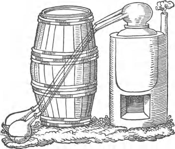
Fig. 76. Destilliergerät mit Kühlfaß nach einem Holzschnitte vom Jahre 1567.
