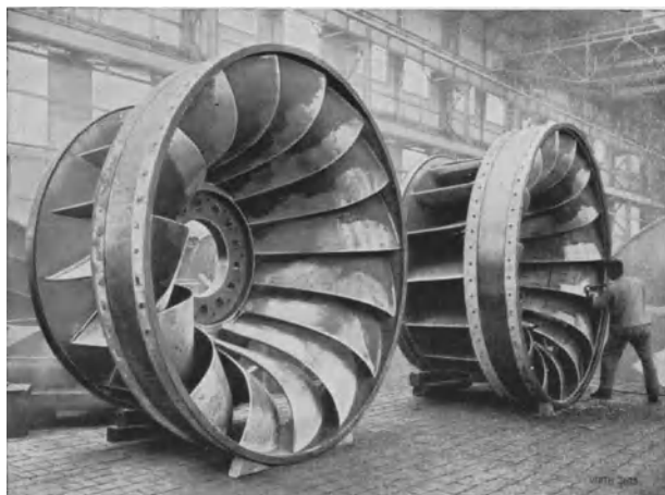
Abb. 152. Laufräder einer Francisturbine. (Voith.)
