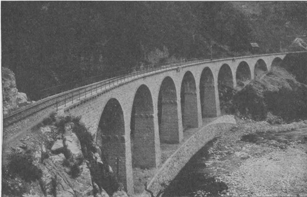
Abb. 43. Die Tennetschluchtbrücke. Blick flußaufwärts.
