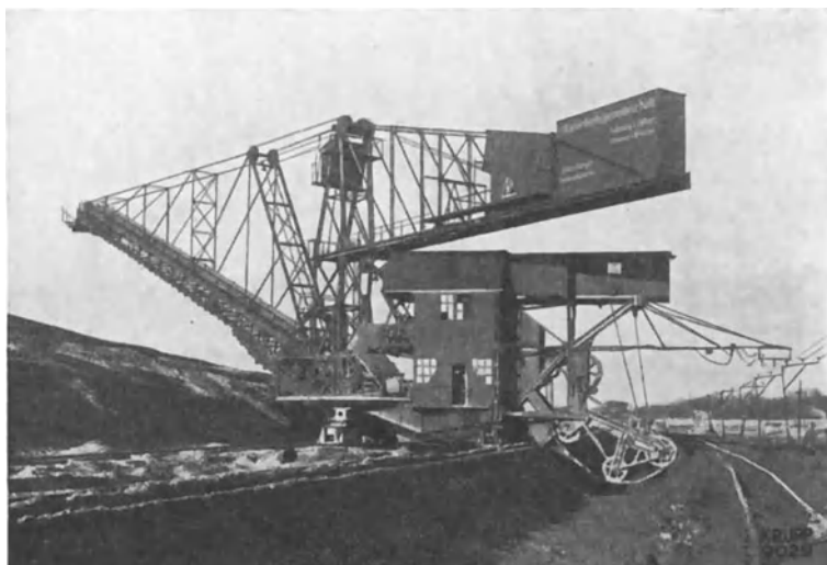
Abb. 52. Kruppscher Schwenkabsetzer.
