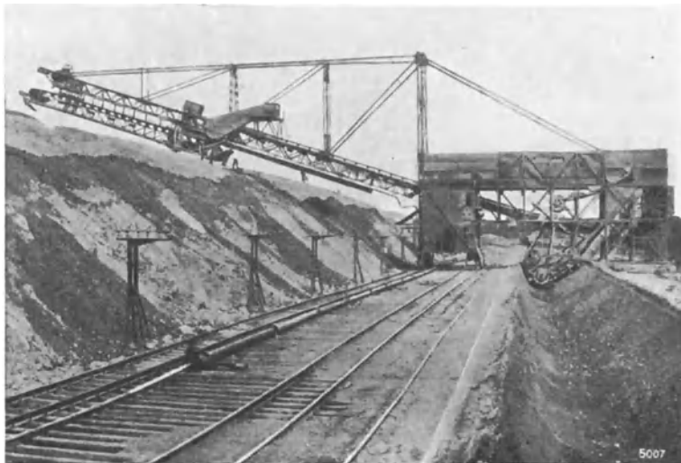
Abb. 51. Kruppscher Absetzapparat mit Doppelbandtransporteur.
