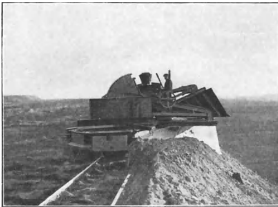
Abb. 48. Planierpflug System Lauchhammer beim Abräumen der geschütteten Massen.
