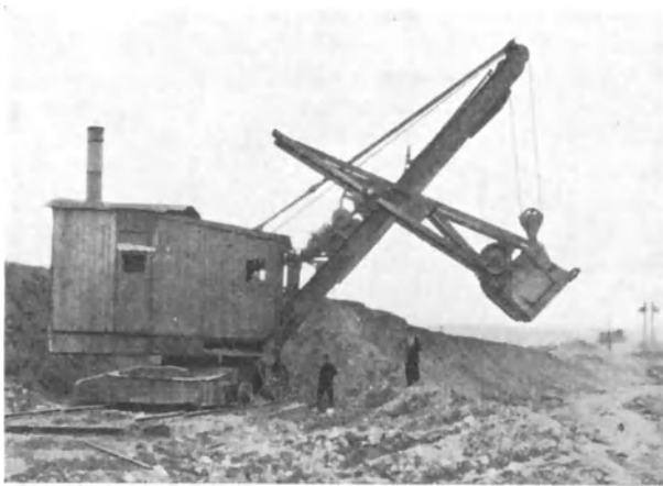
Abb. 11. Löffelbagger, Modell G 20 von Menck & Hambrock.
