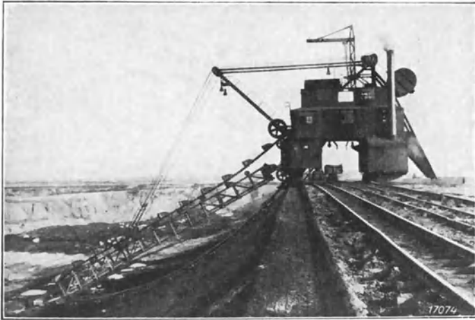
Abb. 1. Portalbagger, Type E II der L.M.G. mit Dampfantrieb.
