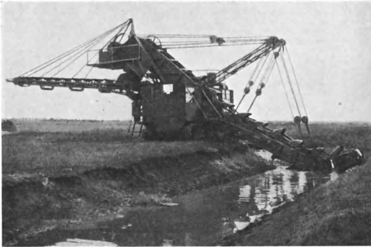
Abb. 5. Raupenbagger, Type R III s der L.M.G. mit Transporteur für Kanalbaggerung.
