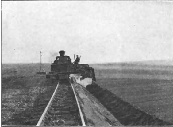
Abb. 47. Planierpflug System Lauchhammer beim Auspflügen einer Mulde.
