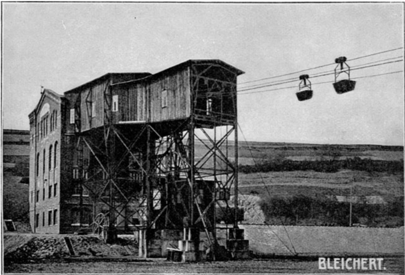
Fig. 241. Außenansicht der Entladestation in Heiligenroda.
