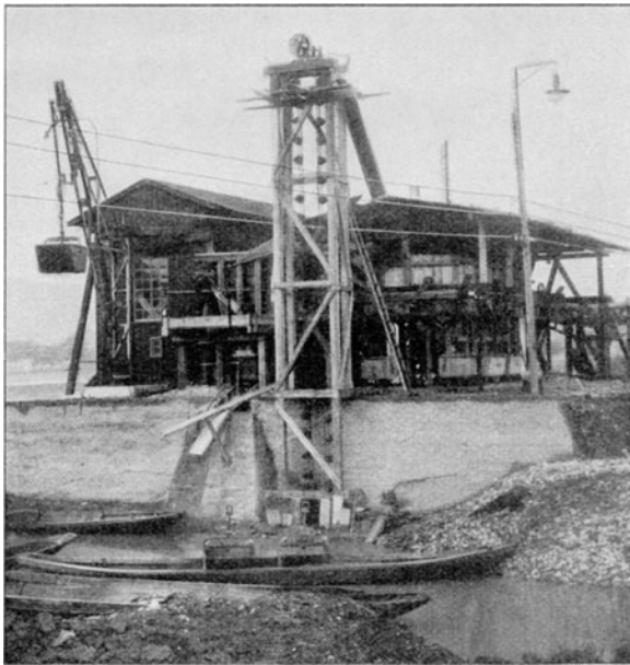
Fig. 248. Drahtseilbahnstation mit Beladekran und Elevator.
