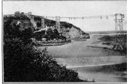
Fig. 84. Streckenbild der Orconerabahn bei Poveneta.
