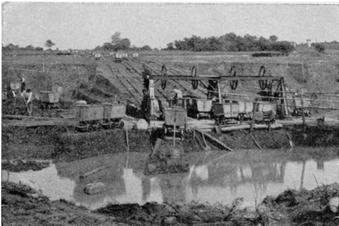
Fig. 61. Seilförderanlage für die Drahtseilbahn Itzehoe.
