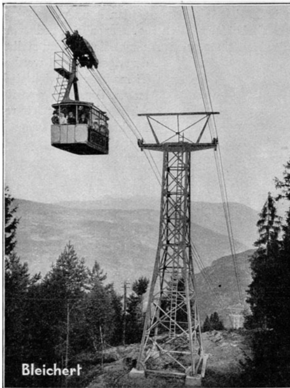
Fig. 280. Streckenbild der neuen Kohlererbahn.
