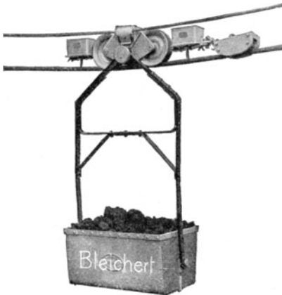
Fig. 272. Tragschmierapparat für kurze Bahnen.
