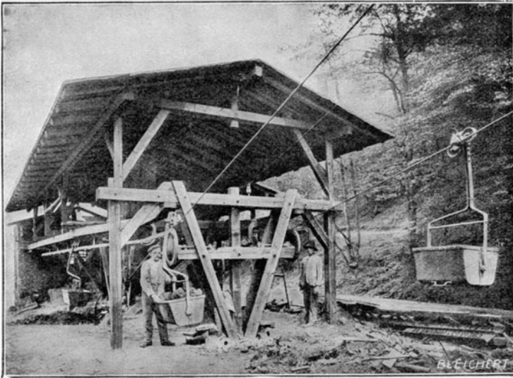
Fig. 204. Beladestation einer Einseilbahn.
