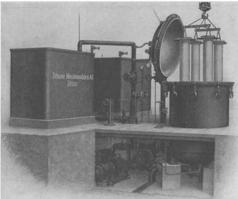
Abb. 113. Färbeapparat für vier stehende Kettbäume. (Zittauer Maschinenfabrik A.-G. Zittau.)
