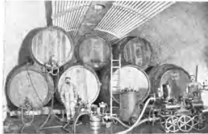
Fig. 16. Lagerkellerkühlung.
