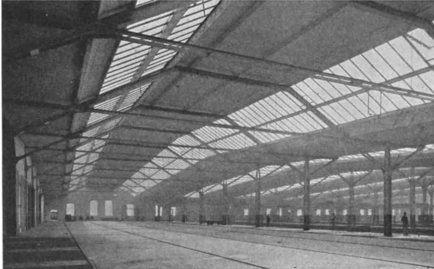
Abb. 385. Haupttype II f;  $a = 25$  m,  $b = 11$  m. Eisenbahnhauptwerkstätte Delitzsch. Ausführung der Stahlkonstruktion: MAN. Baujahr 1906.
