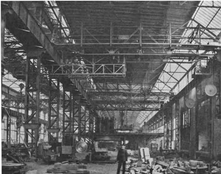
Abb.190. Laufkran mit Auslegerkatze. Tragkraft 10 t,  $s = 18$  m. Ausführung Demag.
