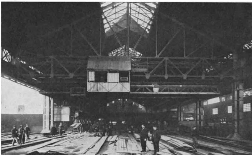
Abb. 182. Laufkran mit Auslegerkatze. Ausführung Demag.
