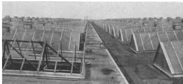
Abb. 361. Haupttype Ic. Eisenbahnwerk Schweidnitz. Ausführung des Glasdachs: J. Eberspächer. Baujahr 1924.
