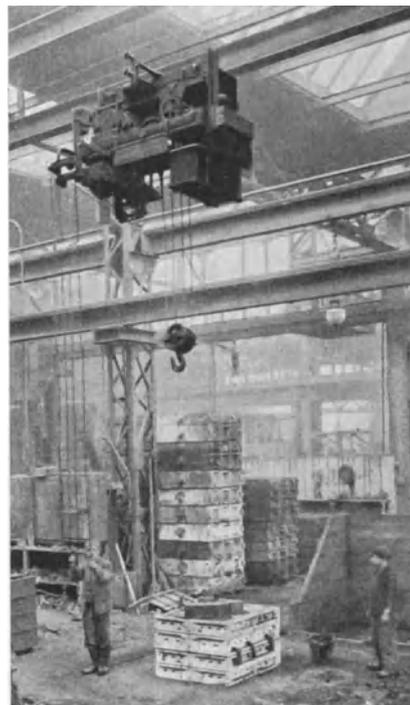
Abb. 141. Laufkatze vom Fußboden aus bedient. Ausführung M. E.
