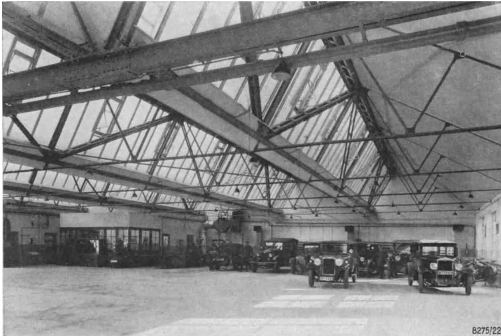
Abb. 431. Haupttype IV, f, Variante;  $a = 7$  m,  $b = 25,4$  m,  $b_1 = 4,7$  m. Eisenmann Werke A. G. Breslau, Vertretung der Robert Bosch A. G. Ausführung der Stahlkonstruktion: Fisch & Co. Breslau.
