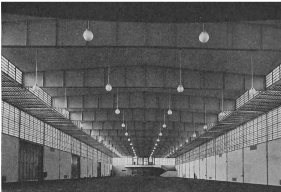
Abb. 215. Halle 7 der Bauausstellung Berlin. Ausführung der Stahlkonstruktion: Breest & Co. Glaseisenbeton System Luxfer. Baujahr 1928.
