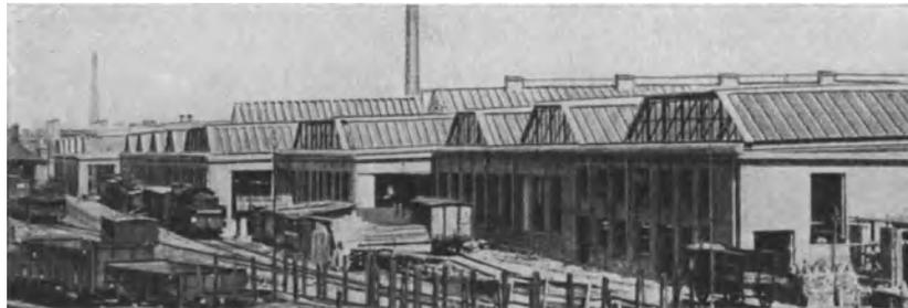
Abb. 377 a. Haupttype II f;  $a = 17$  m,  $b = 11$  m. Wagenbauwerkstätte Kassel.
