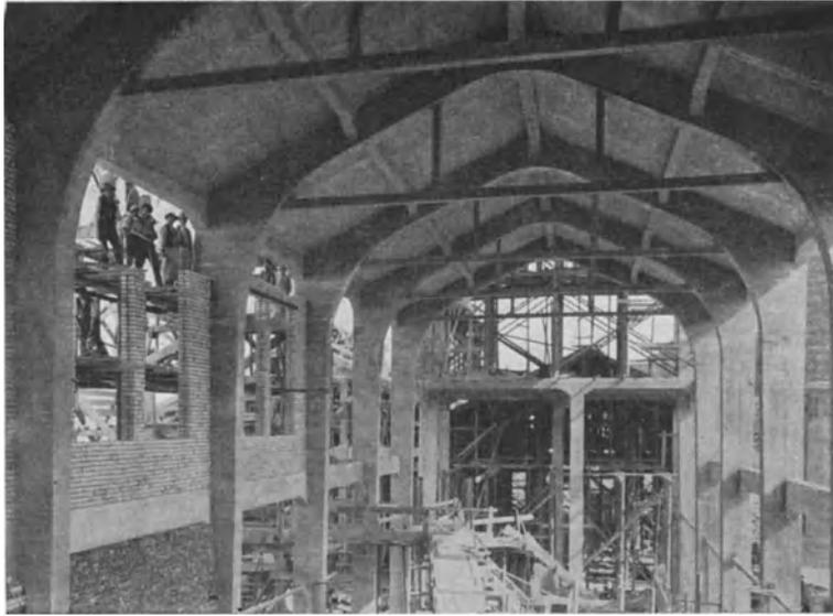
Abb. 274. Ofenhaus der Portlandzementfabrik A. Märker, Harburg. Ausführung: Wayss & Freytag A. G.
