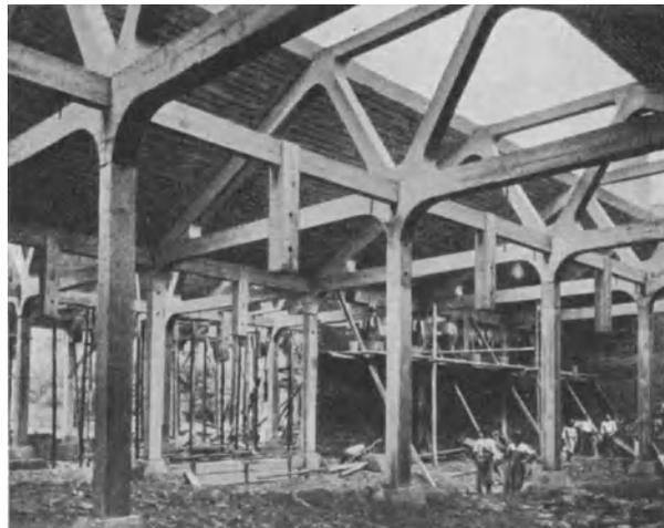
Abb. 395b. Haupttype IIIc;  $a = 8$  m,  $b = 4,9$  m. Deckenfabrik Nagold.
