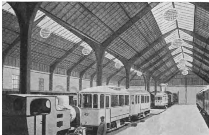
Abb. 389. Haupttype IIIa.  $a = 14$  m,  $b = 10$  m. Verkehrshalle der Deutschen Werkbundaussstellung Köln. Ausführung der Stahlkonstruktion: Breest & Co., Berlin. Baujahr 1914.
