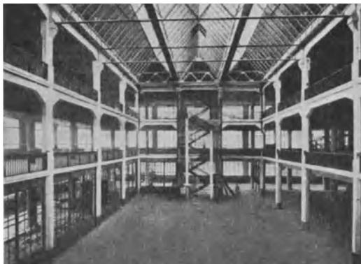
Abb. 528. Deutsche Waffen- u. Munitionsfabrik, Karlsruhe. Ausführung der Eisenbetonkonstruktion: Dywidag.
