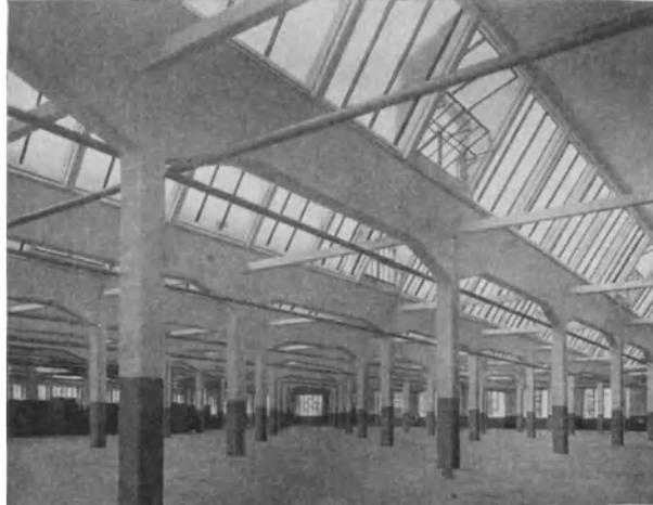
Abb. 405. Haupttype IV, b;  $a = 6$  m,  $b = 9$  m. (Decke zwischen First- und Traufpfette gespannt.) Waffenfabrik Steyr. Ausführung: Wayss & Freytag A. G. Baujahr 1913/14.
