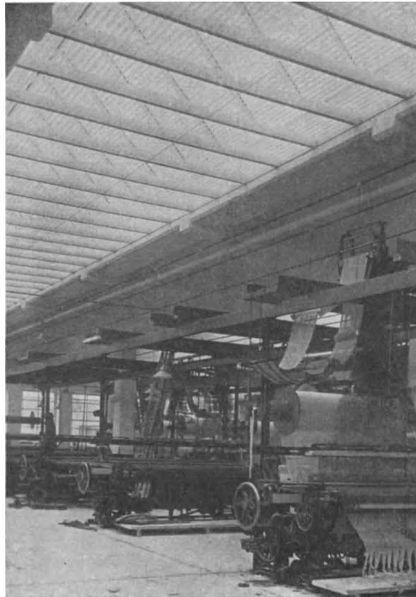
Abb. 347. Sonnenschutzvorrichtung beim Fabrikbau der Firma J. G. Lieske & Häbler, Großschönau.
