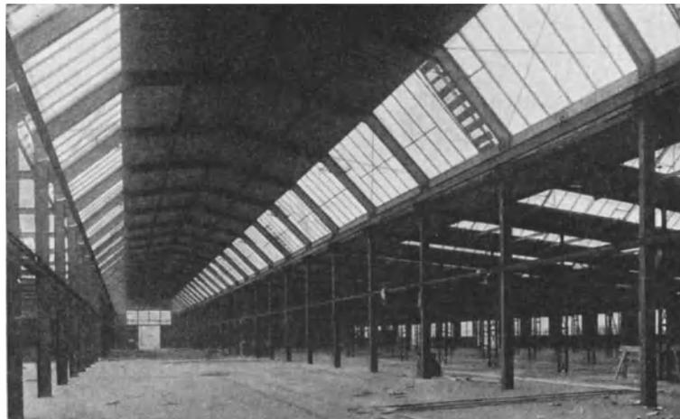
Abb. 533. Holzbearbeitungsfabrik Spandau. Ausführung der Stahlkonstruktion: Breest & Co. Baujahr 1916.
