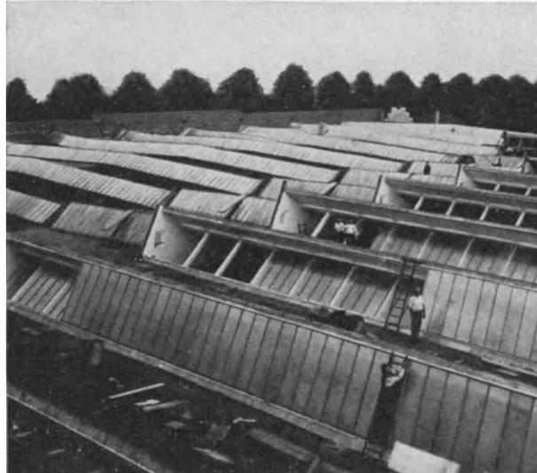
Abb. 409a. Haupttype IV, b;  $a = 6,9$  m,  $b = 6,9$  m. Kammgarnspinnerei Leipzig A. G. Ausführung: Ed. Züblin & Co. Baujahr 1907.
