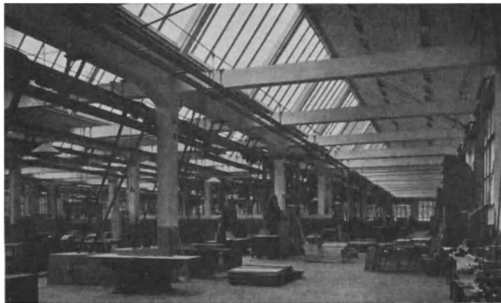
Abb. 406. Haupttype IV, b;  $a = 7,50$  m,  $b = 9,24$  m. Waffenfabrik Mauser A. G. Oberndorf. Ausführung: Dywidag. Baujahr 1915/17.
