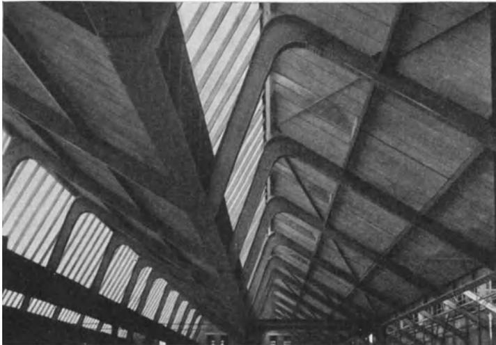
Abb. 416a. Haupttype IV, c Variante;  $a = 8$  m,  $b = 6 \cdot 5,125 = 30,75$  m. I. P. Bemberg A. G. Barmen. Ausführung der Stahlkonstruktion: Hein, Lehmann & Co. A. G. Baujahr 1929.
