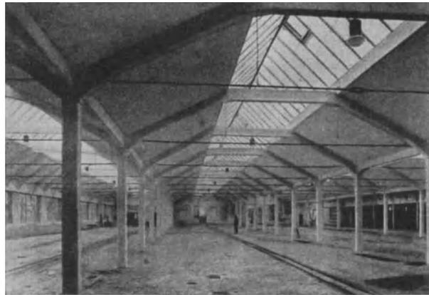
Abb. 392. Haupttype IIIb;  $a = 10$  m,  $b = 7,10$  bis  $8,20$  m. Opelwerke Rüsselsheim. Ausführung: Wayss & Freytag A.G. Baujahr 1912.
