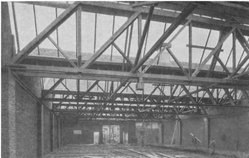
Abb. 429 c. Haupttype IV, f;  $a = 6,10$  m,  $b = 18,40$  m. Ausführung der Holzkonstruktion: Karl Kübler A. G. Baujahr 1919.
