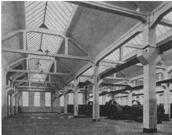
Abb. 393. Haupttype IIIb;  $a = 9,90$  m,  $b = 9$  m. Rheinische Metallwaren- und Maschinenfabrik Düsseldorf-Derendorf. Ausführung: Dywidag. Baujahr 1916/18.
