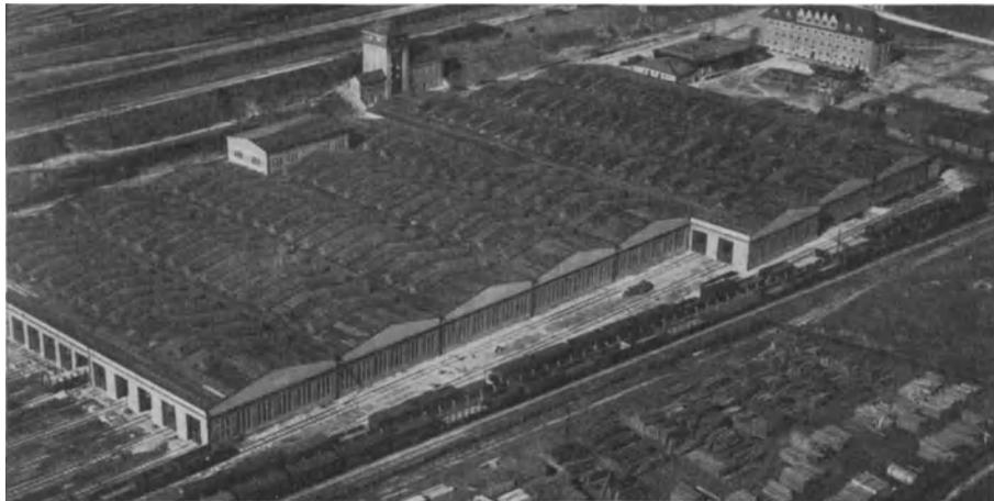
Abb. 358 b. Haupttype Ib;  $a = 25$  bis  $27$  m,  $b = 7$  m. Werkstättenanlage München-Ost der RBD München. Ausführung der Holzkonstruktion: Karl Kübler A.G. Baujahr 1922/23.
