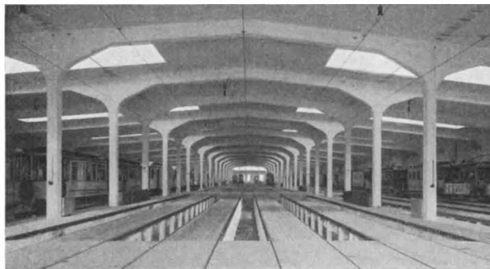
Abb. 353. Haupttype Ia;  $a = 13 + 16 + 13$  m,  $b = 7,5$  m. Straßenbahn-Wagenhalle in Leipzig. Ausführung: A.G. für Bauausführungen Hoch-, Tief- und Eisenbetonbau Leipzig. Baujahr 1924/25.
