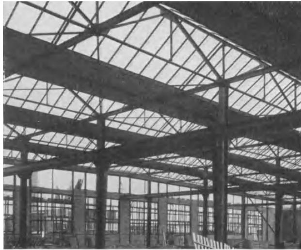
Abb. 360. Haupttype Ic;  $a = 20$  m,  $b = 10$  m. Signalfabrik Henningsdorf der AEG. Ausführung der Stahlkonstruktion: Breest & Co.
