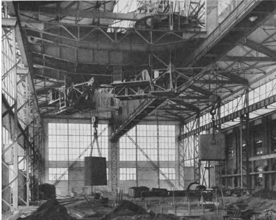
Abb. 175. Laufkrane mit Drehlaufrkatzen. Tragkraft 30 t,  $s = 13$  m. Ausführung MAN.
