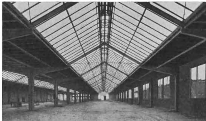
Abb. 374. Haupttype II d;  $a = 20\text{ m}$ ,  $b = 8\text{ m}$ . Porzellanfabrik der AEG Henningsdorf. Ausführung der Stahlkonstruktion: Breest & Co., Berlin.
