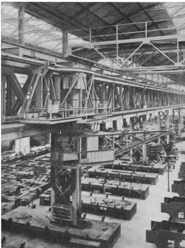
Abb. 191. Konsoldrehkran mit vollem Drehkreis. Ausführung Karl Flohr A. G., Berlin.
