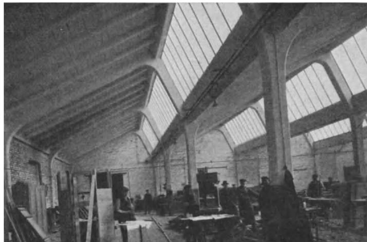
Abb. 412. Haupttype IV, c.  $a = 6,7$  m,  $b = 6$  m. Ed. Züblin & Co. A. G. in Kehl. Ausführung: Ed. Züblin & Co. Baujahr 1908.
