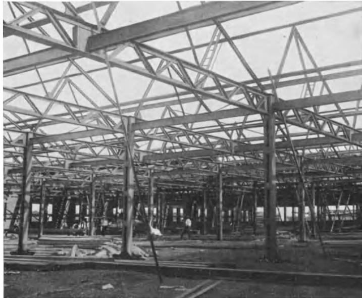
Abb. 419. Haupttype IV, d.  $a = 13,0$  m,  $b = 5,5$  m. Neckarsulmer Fahrzeugwerke, Werk Heilbronn. Ausführung der Stahlkonstruktion: E. Mehne, Heilbronn.
