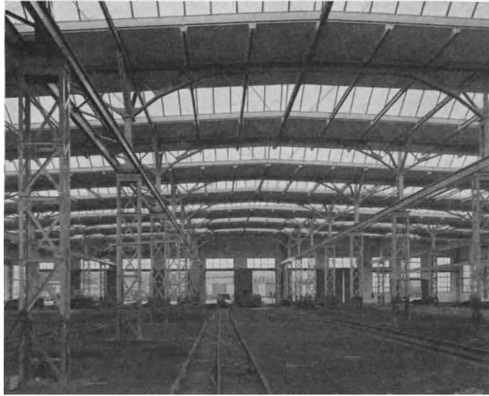
Abb. 356. Haupttype Ia, Variante;  $a = 12$  m,  $b = 8$  m. Untergestellschlosserei der ME. Entwurf des Verfassers.
