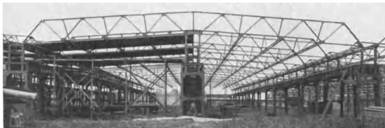
Abb. 362. Haupttype Ic;  $a = 16,5$  m,  $b = 11,25$  m. Neubau Wanderer-Werke Sigmar. Ausführung der Stahlkonstruktion: MAN. Baujahr 1925.
