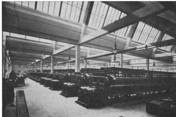
Abb. 404. Haupttype IV,  $a = 7,5$  m,  $b = 5,4$  m. (Dachdecke zwischen die Binder gespannt.) Kammgarnspinnerei Gautzsch A. G. Ausführung: Kell & Löser A. G. Baujahr 1925.
