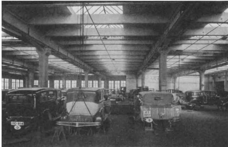
Abb. 369. Haupttype IIb;  $a = 10,2$  m,  $b = 15,0$  m. Daimler-Benz A.G., Werk Untertürkheim. Ausführung: Wayss & Freytag A.G. Baujahr 1922.
