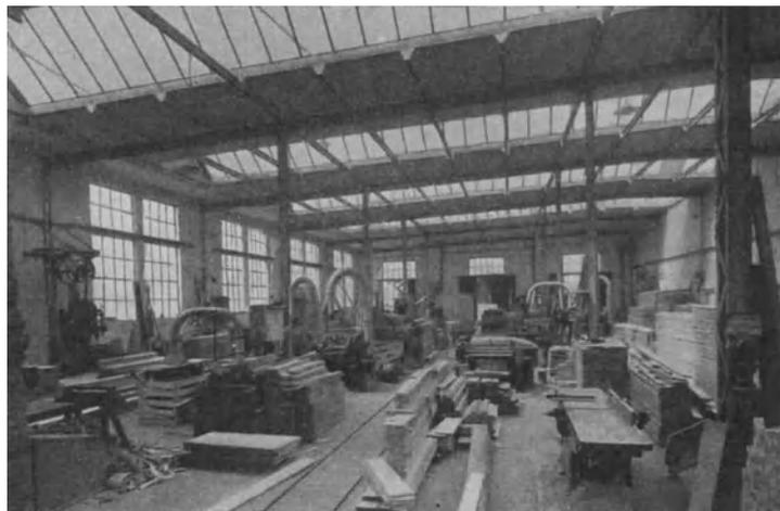
Abb. 351. Haupttype Ia;  $a = 8$  m,  $b = 8$  m. Holzbearbeitungswerkstätte der ME. Entwurf des Verfassers. Baujahr 1910.
