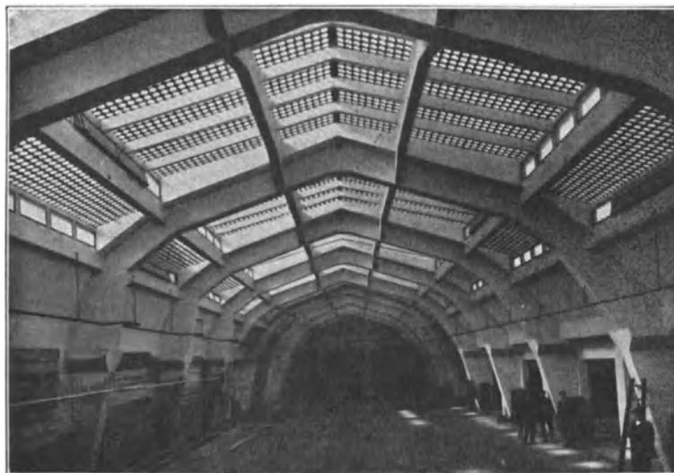
Abb. 76a. Maschinenbauhalle der Firma Carl Zeiss, Jena. Betongläser, System Solfac.
