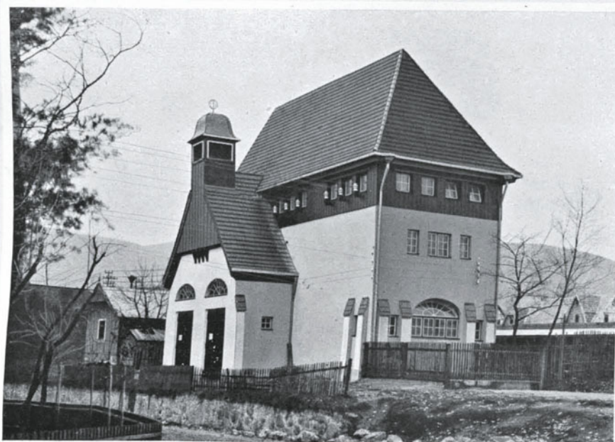
Transformatorstation Mehlis (Thür. E. L. G.)
