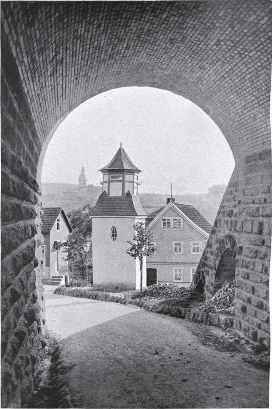
Transformatorstation Domberg, Suhl (Thür. E. L. G.)
