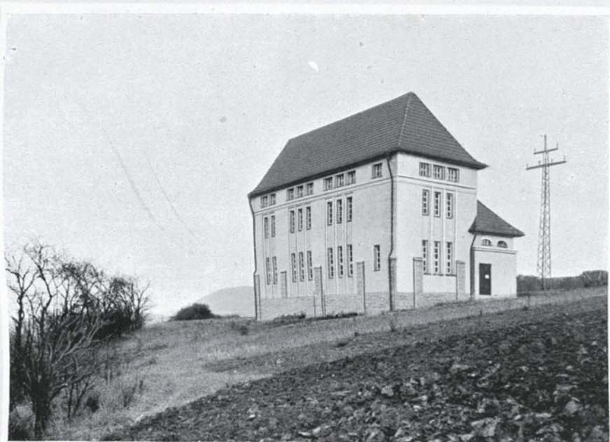
Transformatorstation Meiningen (Thür. E. L. G.)
