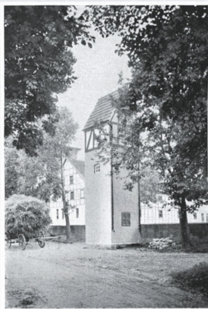
Station Gräfontonna (Thür. E. L. G.)
