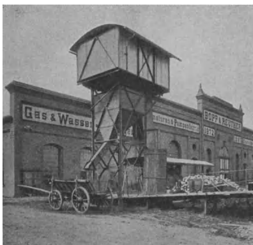
Abb. 366. Schuttabfuhranlage mit Eisenrückgewinnung.
