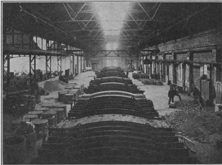
Abb. 284. Glühofenhalle für 8 gasgefeuerte Temperöfen.
