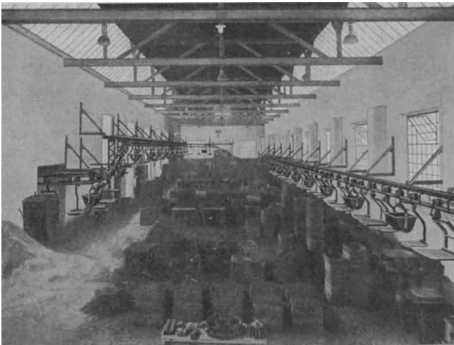
Abb. 361. Hängebahn mit Kippschaukeln.
