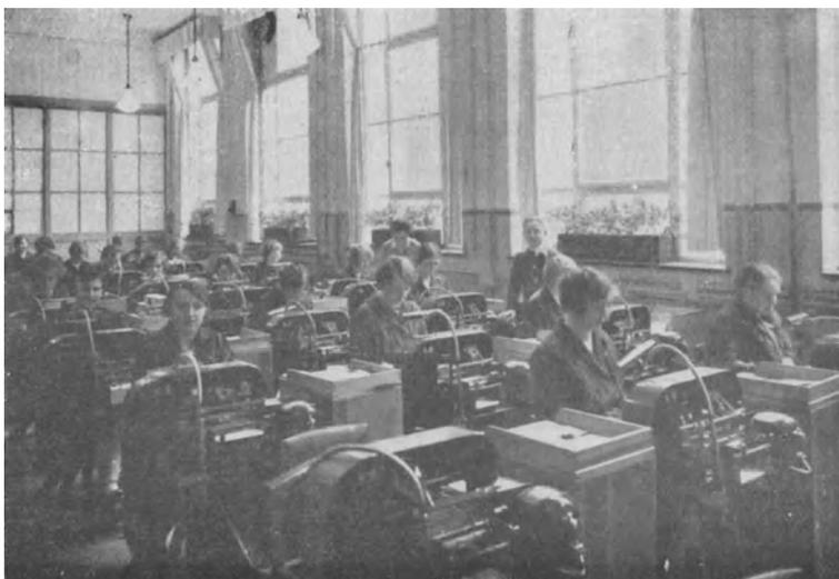
Abb. 15. Stark besetzter Rechenmaschinenraum. Gute Belichtung; gute Allgemein- und Einzelplatzbeleuchtung.
