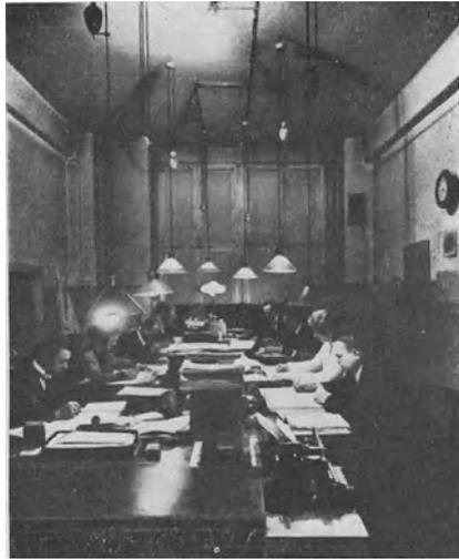
Abb. 11. Schlechte Bürobeleuchtung durch Pendel mit ungeeigneten Reflektoren.
