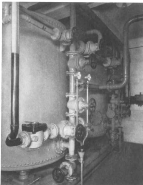
Abb. 10. Mittlere Neopermutitanlage in einem rheinischen Hotel.
