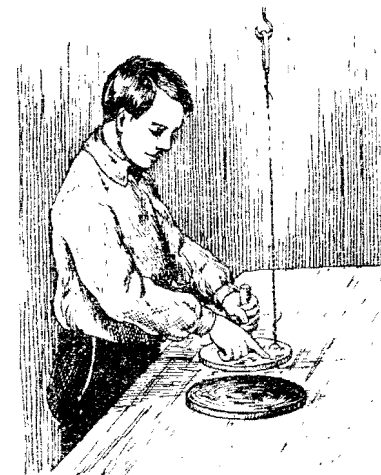
Рис. 57. Вибратор из электрофора, и прикрепленная к нему проволока—антенна.
