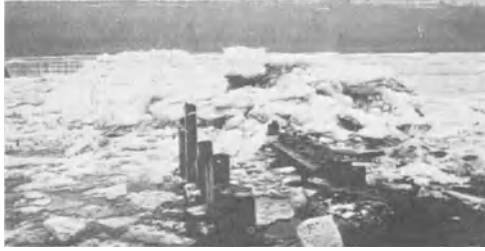
Abb. 181. Ein Eisstoß schiebt sich über einen Fangdamm
