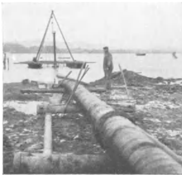
Abb. 381. Verlegung der Rohrleitung zur Entnahme von Wasser aus einem See. (A. Guggenbühl A. G., Zürich)
