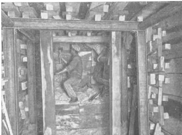
Abb. 667. Stollenvortrieb unter der Untergrundbahn in Berlin für einen Kanal
