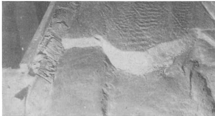
Abb. 173. Verlandung eines Staupraumes mit übermäßiger Breite
