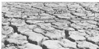
Abb. 260. Schwindrisse in den Schlammablagerungen des Langmannweiher der Teigtischwerke
