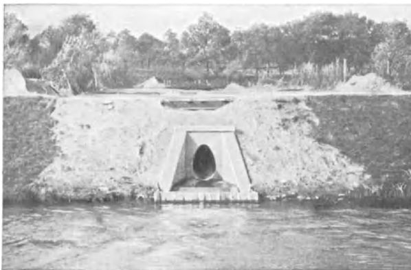
Abb. 512. 1) Auslaufbauwerk am Teltowkanal in Berlin
