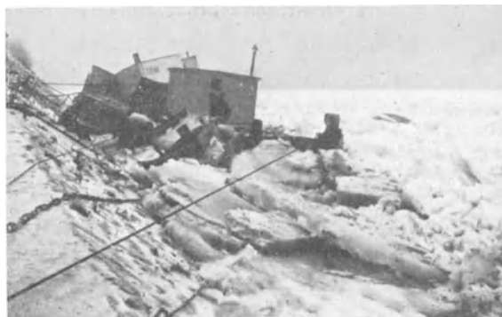
Abb. 180. Eine Landungsstelle in der Donau bei Preßburg wird vom Eis ans Ufer gedrückt
