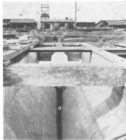
Abb. 551. Absitzbecken der Kläranlage München-Großlappen. a Schlitz. (Dyckerhoff & Widmann)
