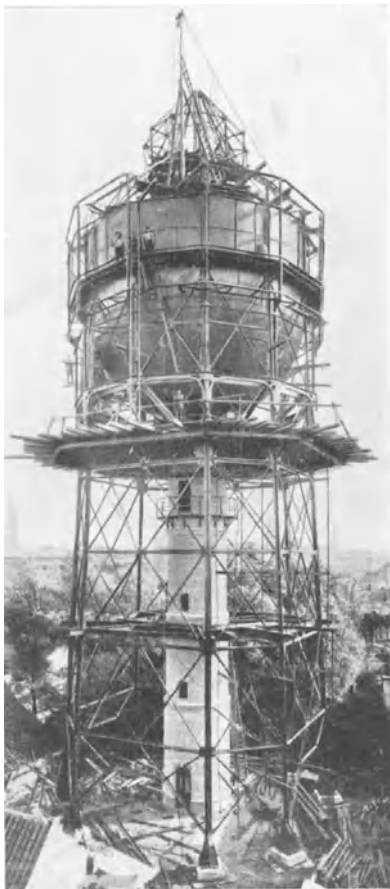
Abb. 423. Barkhausen-Behälter für 1000 m 3 in Groningen. (A. Wilke & Co., Braunschweig)
