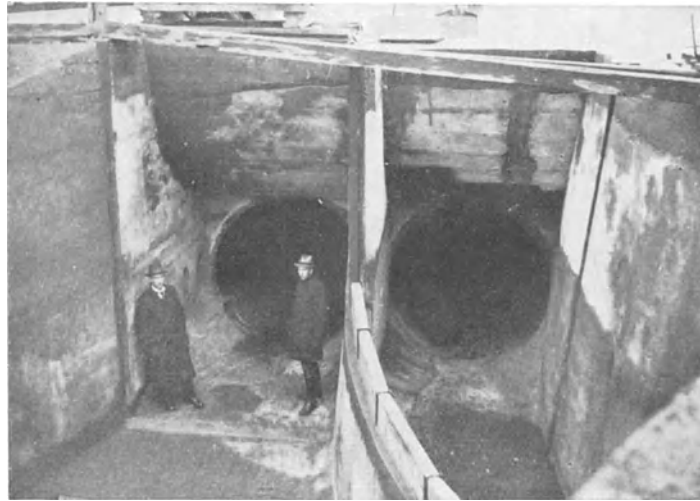
Abb. 510. Der Einlauf zu den Auslaufrohren der Emscher Ausmündung in den Rhein mit dem Überlauf zum nichtausgemauerten Rohr
