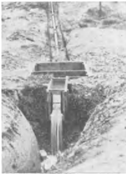
Abb. 78. Meßwehr für die Beobachtung einer Quelle. (O. Lettovsky)
