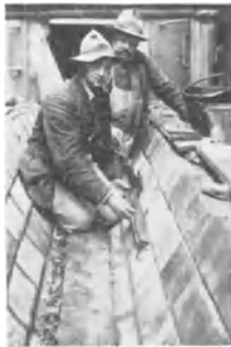
Abb. 627. Vergießen der Fugen zwischen den Steinzeugplatten mit Asphalt. (Ing. Kraus, Graz)
