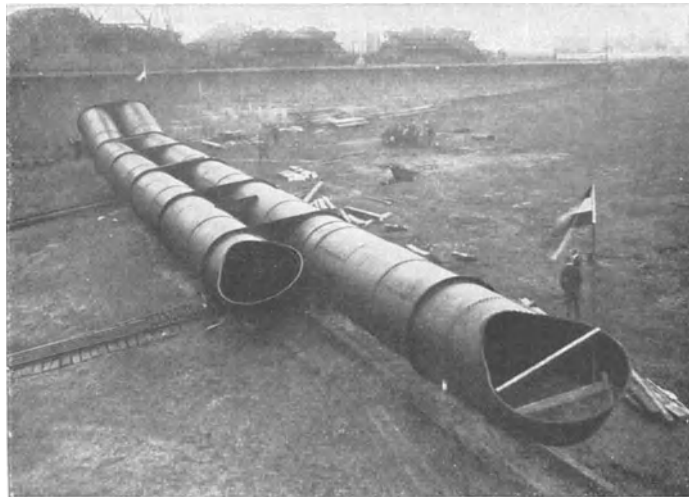
Abb. 507. Stapellauf der Rohrleitung, die mit Winden auf der Gleitbahn zu Wasser gelassen wird
