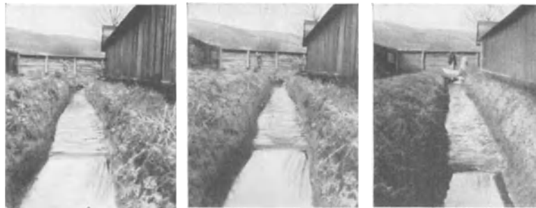
Abb. 138. Ansichten verschieden hoher Füllschwalle
