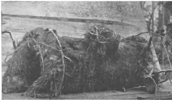
Abb. 653. Verwurzelung einer Steinzeugleitung
