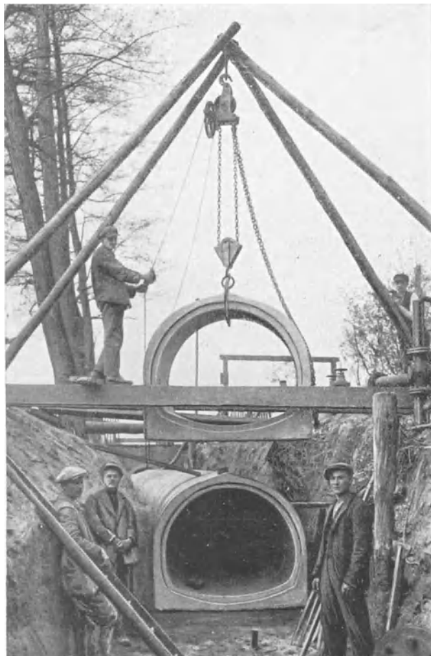
Abb. 623. Verlegung eines Kanals aus fabriksmäßig hergestellten Rohren mit Maulquerschnitt
