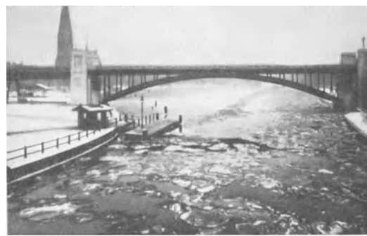
Abb. 184. Eistrieb am Kuhmühlteich in Hamburg. Stärke des Eistriebes \varepsilon = 0,4
