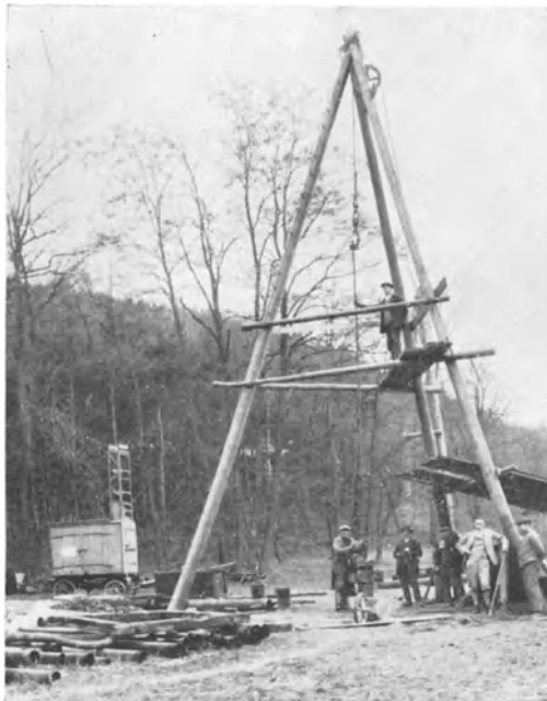
Abb. 345. Bohrung für die Rohrbrunnen von Saaz. (J. Bill u. Co., Aussig)
