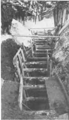
Abb. 481. Gepölzter Rohrgraben, 7 m tief. (S. Juhász, Graz)
