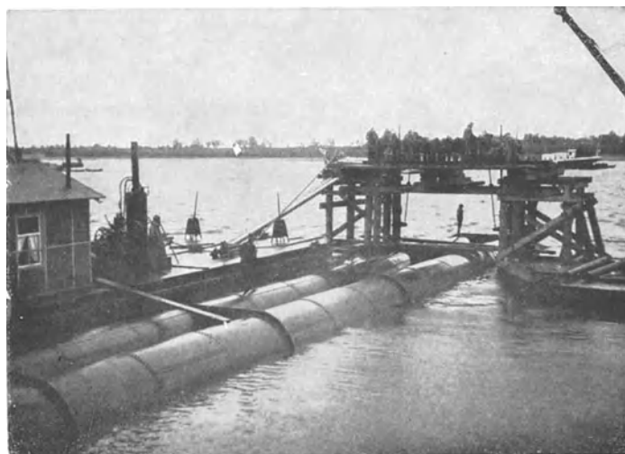
Abb. 509. Die Versenkung der an zwei Böcken aufgehängten Auslaufrohrleitung in die im Rheinbett vorgebagerte Rinne
