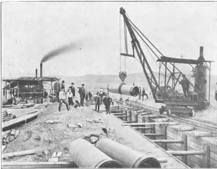
Abb. 483. Verlegen einer Rohrleitung. (Nach Wahl)
