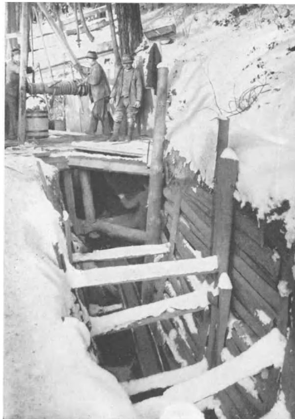
Abb. 331. Fassung einer Spaltquelle in einem 12 m tiefen Schacht; die Ableitung liegt 7 m unter dem Gelände. (S. Juhász, Graz)
