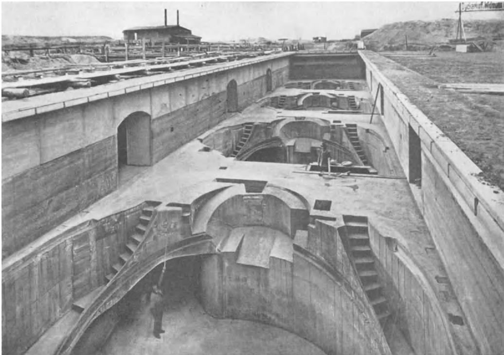
Abb. 526. Unterbau der Rienschen Siebscheiben in der Abwasser-Reinigungsanlage Dresden-Kaditz. (Dyckerhoff & Wydmann)
