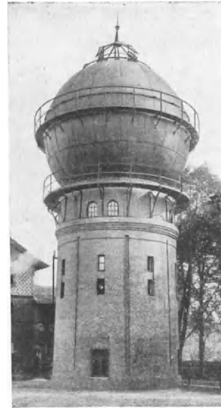
Abb. 426. Klönne-Behälter für 300 m³ in Börsum. (A. Wilke & Co., Braunschweig)
