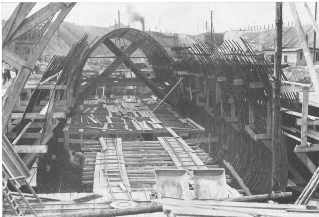
Abb. 673. Emscherüberbrückung Dortmunderfeld. (Dyckerhoff & Widmann)
