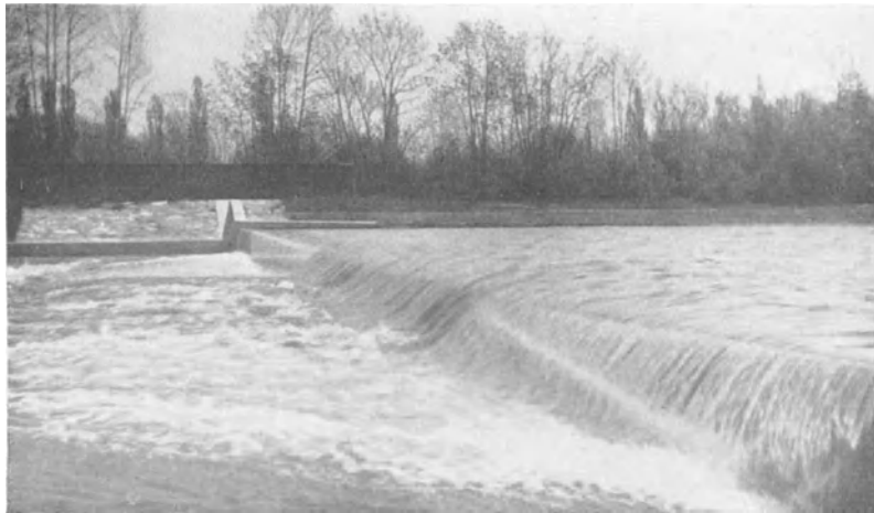
Abb. 128. Wasseranstieg unter einem belüftetem Überfallstrahl
