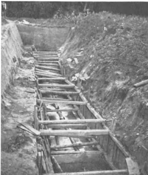
Abb. 325. Sammelstrang aus gelochten Steinzeugrohren. (S. Juhász, Graz)
