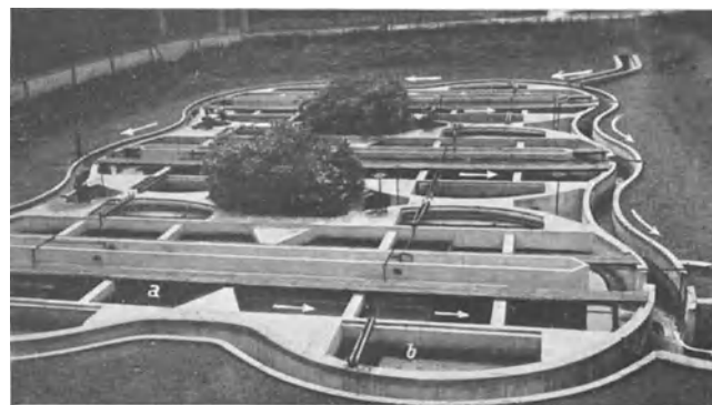
Abb. 575. Die Emscherbrunnen in Essen-Rellinghausen. a Absitzraum, b Faulraum. (K. Imhoff, Essen)
