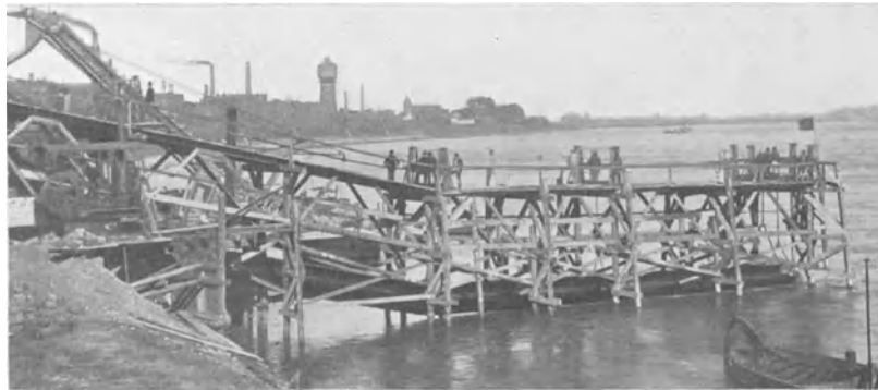
Abb. 511. Verlegung des eisernen Kanalauslaufrohres in den Rhein in Crefeld. (Dyckerhoff & Widmann)
