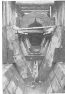
Abb. 628. Schalung für das weitere Betonieren des Kanals. (Ing. Kraus, Graz)
