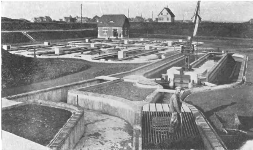
Abb. 516. Die Kläranlage Herne-Nord, 12 Emscherbrunnen für 60000 Einwohner
