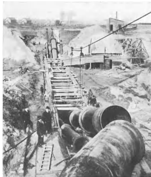
Abb. 698. Bau des Dükers unter dem Rhein-Herne-Kanal. (Dyckerhoff & Widmann)
