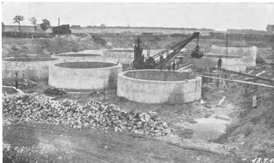
Abb. 542. Herstellung der Emscherbrunnen als Senkbrunnen in Herne-Nord Schoklitsch, Wasserbau
