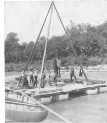
Abb. 245. Erkundung der Bodenbeschaffenheit für das Isarwehr bei Unterföhring durch Bohren. (Mittlere Isar A.-G.)
