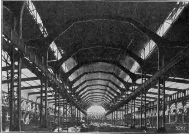
Abb. 71. Mit Zomakdecken eingedeckte Messehalle IX in Leipzig (Lauchhammer-Werke).
