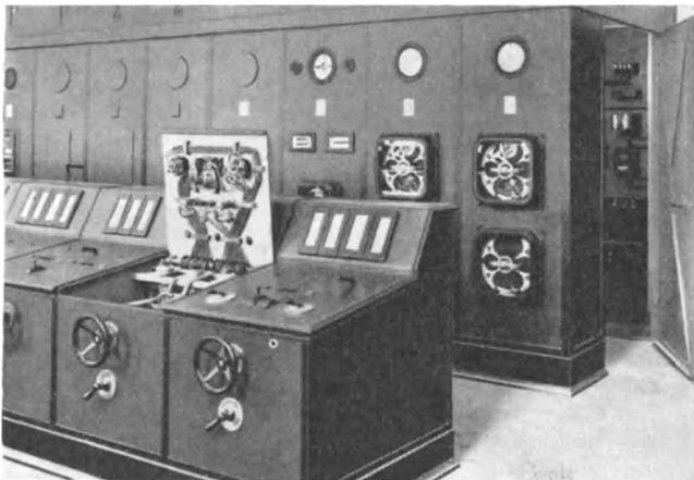
Abb. 426. Freistehendes Schaltpult geöffnet.
