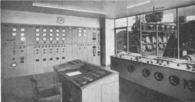
Abb. 428. Schaltwarte eines Dieselmotorkraftwerkes mit Schaltpult für die Maschinen und Schalttafeln für die 15-kV-Verteilung (Ausblick in den Maschinenraum).
