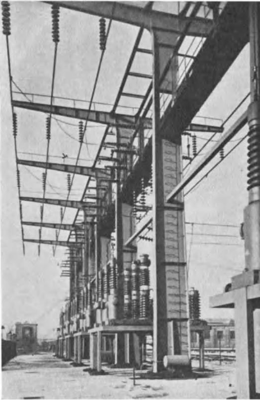
Abb. 449. Ansicht der 100-kV-Freiluftanlage in T-Mast-Bauform (Siemens-Hochbauweise).
