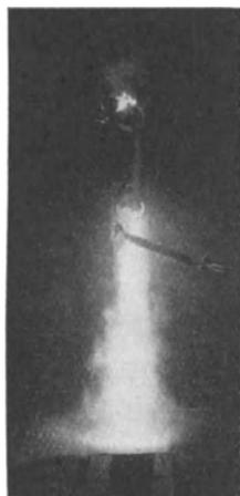
Abb. 256. Auspuffgase (Schaltfeuer) beim Ansprechen einer Hochspannungssicherung älterer Bauart durch Kurzschluß.
