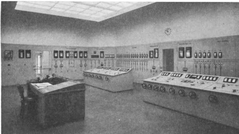
Abb. 433. Schaltwarte mit Schaltpulten für die Maschinen und Schalttafeln für die Verteilungsanlagen.
