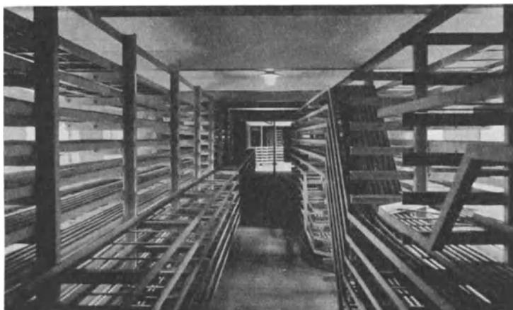
Abb. 438. Kabelkeller für Haupt- und Steuerkabel.
