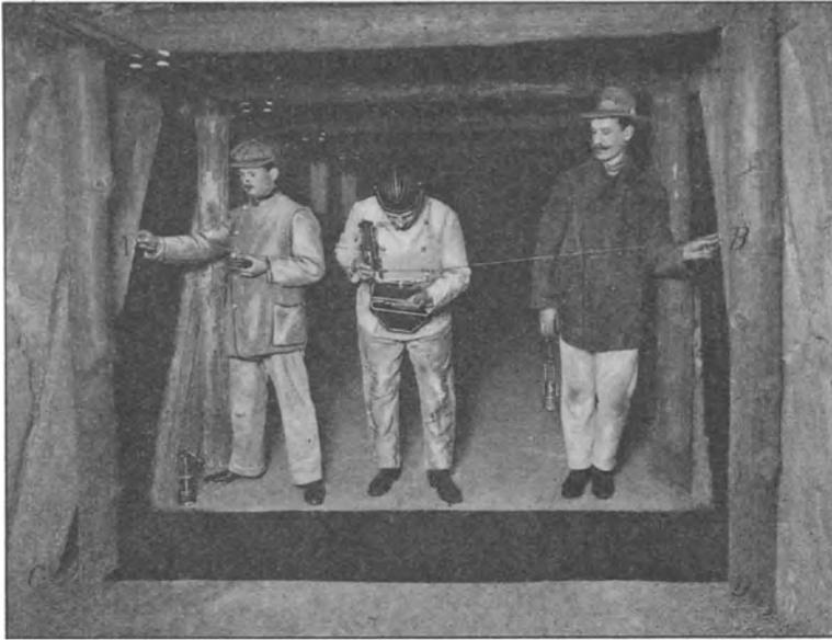
Fig. 164. Bestimmung des Streichens eines querschlägig durchfahrenen Flözes.
