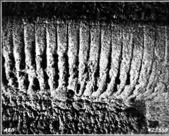
Abb. 248. Werk II. Anfrassungen der Hängedecke. Blickrichtung 9 in Abb. 247.
