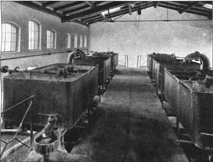
Abb. 60d. Enthärtungsanlage in Berlin-Halensee, Verteilungsbehälter für Rohwasser (innen), Behälter für Kalk- und Sodalösung (außen).
