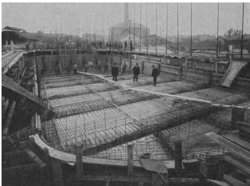
Abb. 99. Durchlaufende Bodenplatte eines Eisenbetonbeckens. (Hallenschwimmbad Nürnberg). Ausführung: Wayss u. Freytag A. G., München. Die Bodenplatte hat eine Breite von 11,5 m und eine Länge von 28,3 m im Lichten. Sie ruht auf Einzelsäulen mit darüberliegenden Unterzügen. Spannweite der durchlaufenden Platten 3 m. Stärke 14 bis 20 cm.
