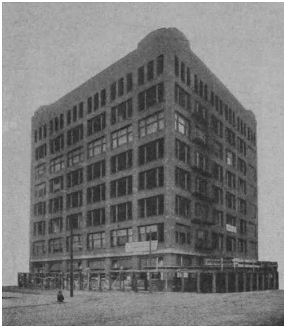
Abb. 93. Zum Abbruch bestimmtes Gebäude in Chicago, in dessen 6.Stockwerk die Belastungsversuche von Talbot und Gonnermann (vgl. Abb. 92) vorgenommen wurden.
