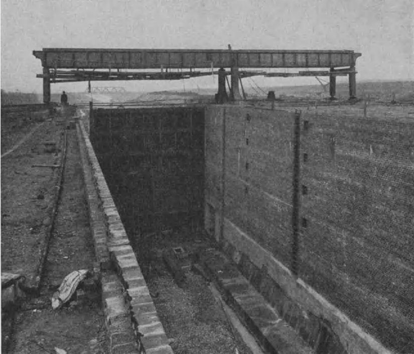
Abb. 87. Rechteckiges Schiebetor in der Schleuse des Rhein-Herne-Kanals.
