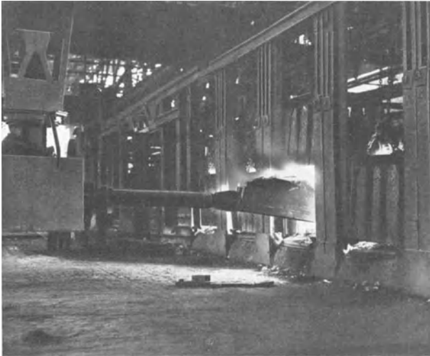
Abb. 44. Beschicken eines Siemens-Martinofens (Beratungsstelle für Stahlverwendung).
