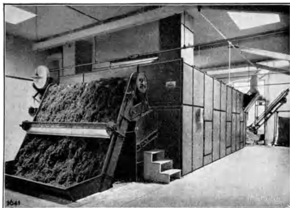
Abb. 119. Bandrockner für lose Wolle. (Benno Schilde, A.-G., Hersfeld).
