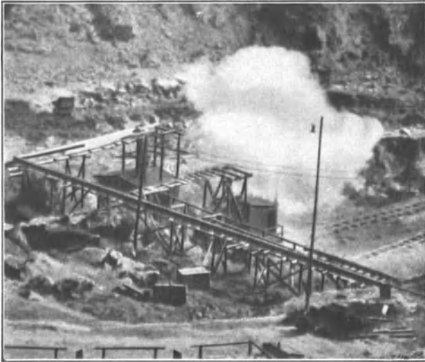
Abb. 99. Sprengungen mit flüssiger Luft beim Bau der Schwarzenbachtalsperre in Baden.
