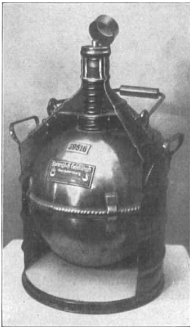
Abb. 18. Sprengluft-Transportgefäß (Mantel aufgeschnitten).
