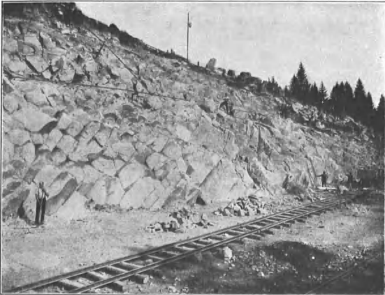
Abb. 94. Steinbruch-Betrieb der Siemens-Bauunion, Forbach in Baden, Sprengluftanlage (Bauart Messer, Leistung 23 ltr/st). Kalksteinwand nach dem Abbohren vor dem Abschlag.
