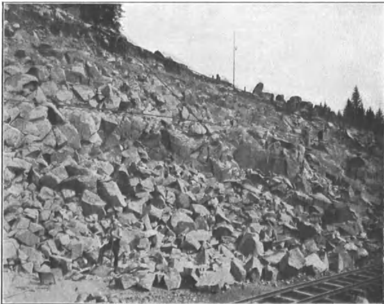
Abb. 95. Steinbruch-Betrieb der Siemens-Bauunion, Forbach in Baden, Sprengluftanlage (Bauart Messer, Leistung 23 ltr/st). Kalksteinwand nach dem Abschlag.
