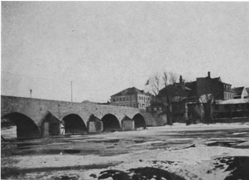
Abb. 2. Unvergrößerte Lochkammeraufnahme. Standpunkt und Richtung der Aufnahme etwa die gleichen wie bei Abb. 1. Lochdurchmesser 0,2 mm. Abstand Loch bis Bild ca. 9 cm.
