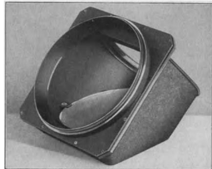
Abb. 348. Umkehrspiegel. Im Gehäuse ist unten ein Teil des elliptisch ausgeschnittenen Planspiegels zu sehen.
