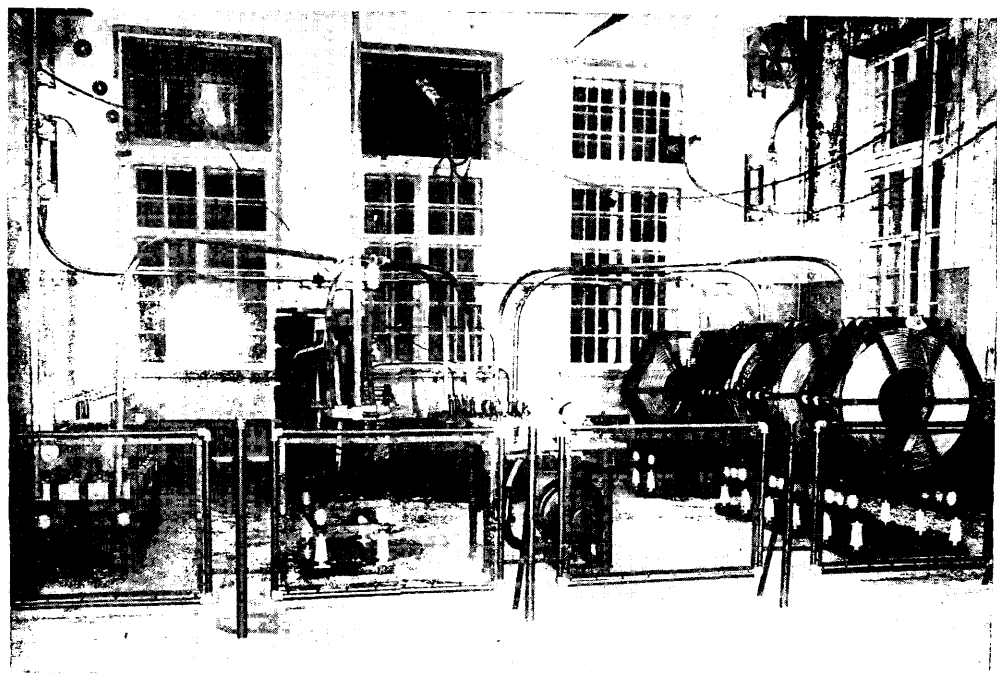
Машинный радиопередатчик Октябрьской радиостанции в 50 kW.
