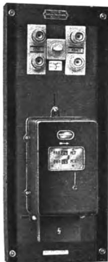
Fig. 378. Münchener Normal-Zählerverteilungstafel für Licht- und Kraft-Münzzähler<sup>1)</sup>.
