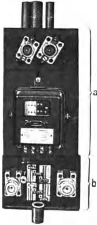
Fig. 400. Ausführung einer Zählerverteilungstafel für die Nürnberger Beisteueranlagen, bei der die Tafel a an den Abzweigkasten b mit Sicherung angebaut ist.
