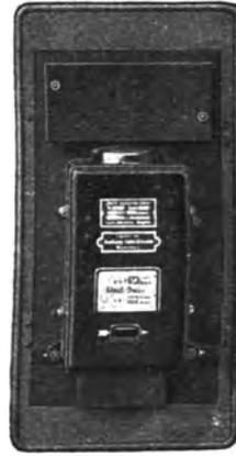
Fig. 374. Einfache Münchener Normal-Zählertafel vor Einführung solcher mit Verteilungssicherungen.
