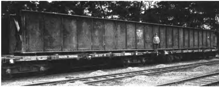
Abb. 48. Transport einer Blechträgerbrücke auf zwei Langwagen.
