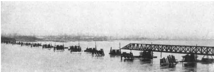
Abb. 34. Längsverschieben eines Brückenstranges.
