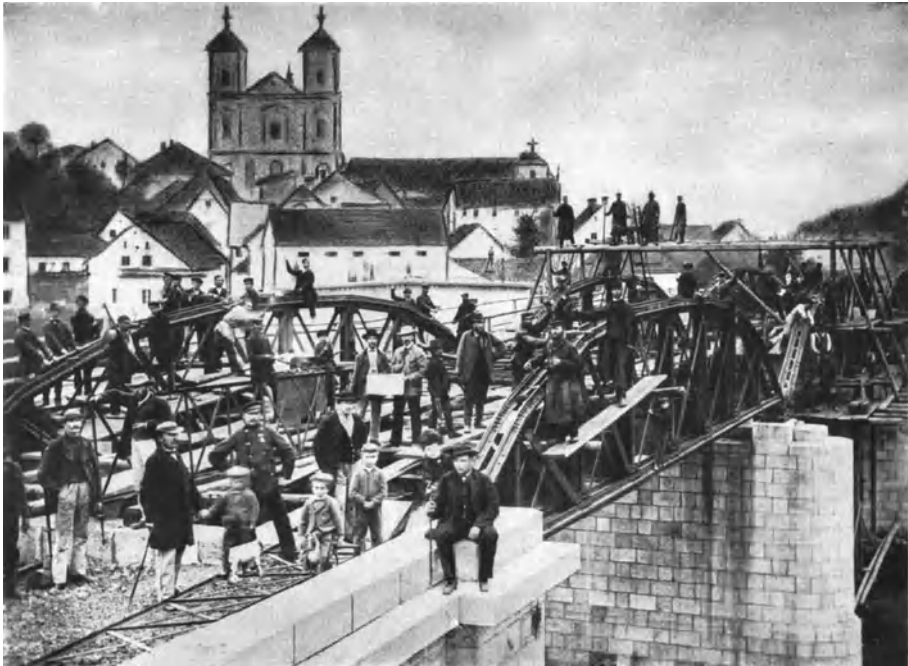
Abb. 1. Brückenmontage in den Jahren 1871/72.
