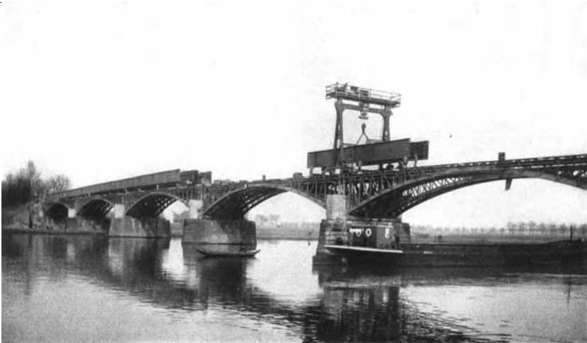
Abb. 57. Montage einer Blechträgerbrücke auf einer Bogenbrücke als Gerüst.
