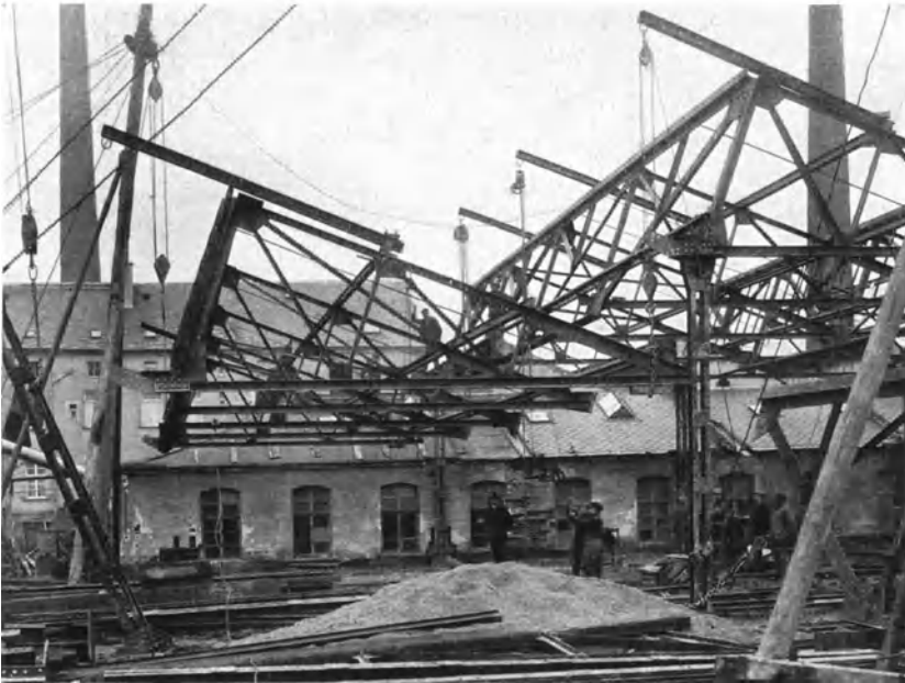
Abb. 91. Montage eines Sägedaches.
