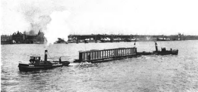
Abb. 50. Wassertransport einer Blechträgerbrücke.
