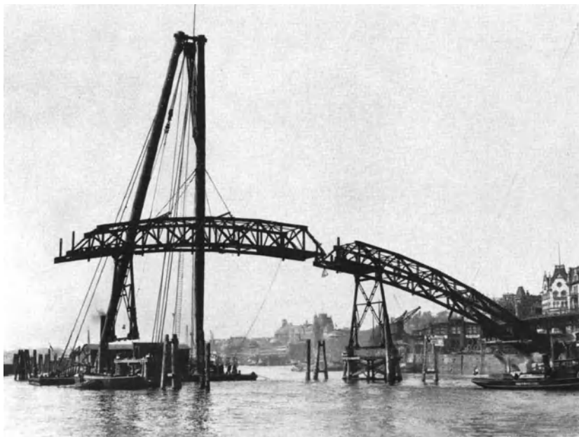
Abb. 40. Bau einer Bogenbrücke mit Schwimmkran.
