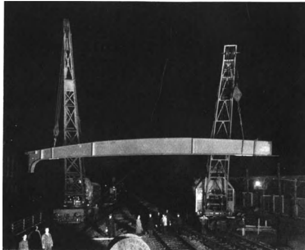
Abb. 65. Riegeleinbau mit Schwerlastkränen.
