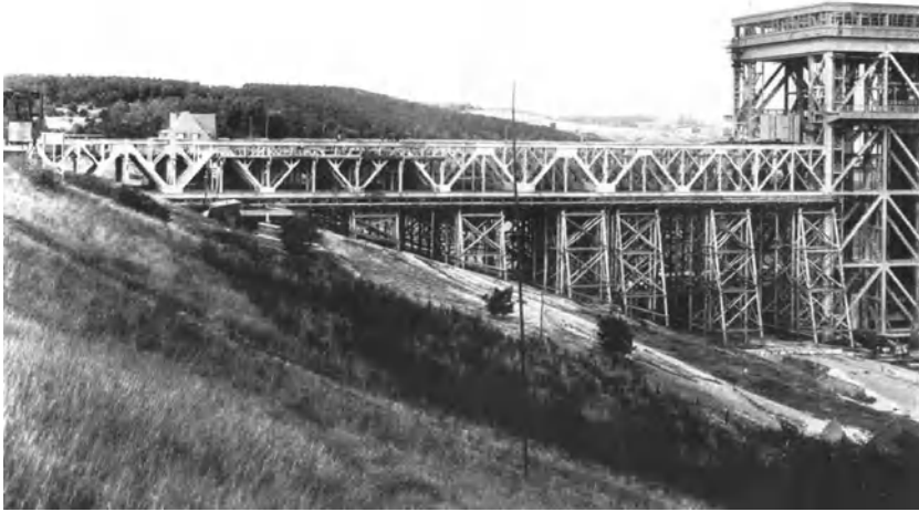
Abb. 13. Gerüst an einem Abhang.
