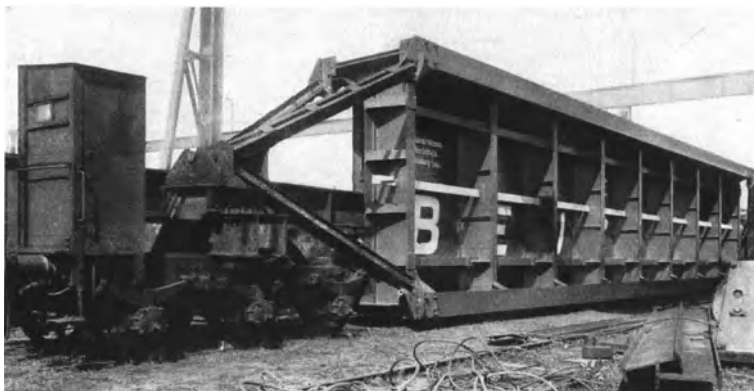
Abb. 49. Transport einer Blechträgerbrücke zwischen zwei Waggons.
