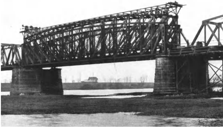
Abb. 27. Montage mit Innengerüst.
