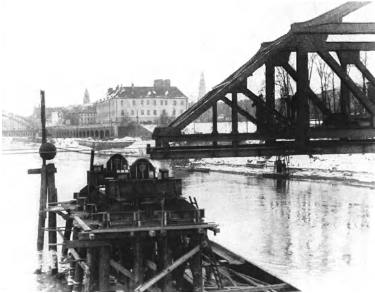
Abb. 33. Längsverschieben einer Brücke.
