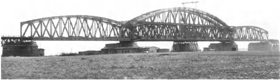
Abb. 17. Gerüstbrücke über große Schiffsfahrtsöffnungen.
