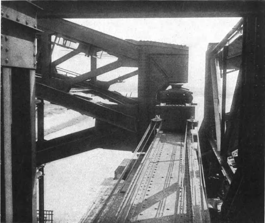
Abb. 32. Verschubvorrichtung für die Brücke der Abb. 31.
