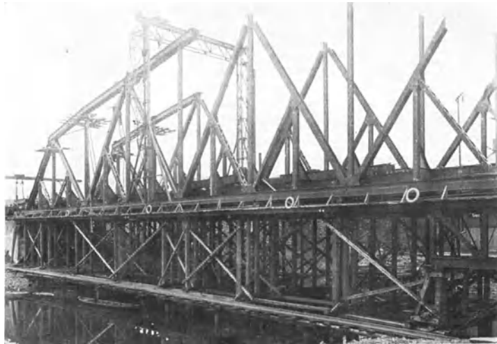
Abb. 21. Montage einer Fachwerkbrücke.
