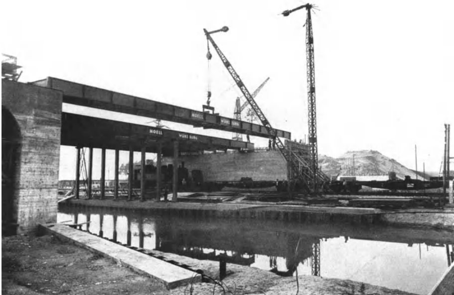
Abb. 53. Verlegen eines Blechträgerbrücken-Abschnittes.
