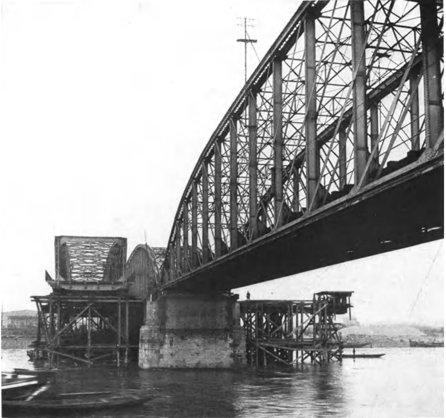
Abb. 29. Brückenauswechslung durch Querverschieben.
