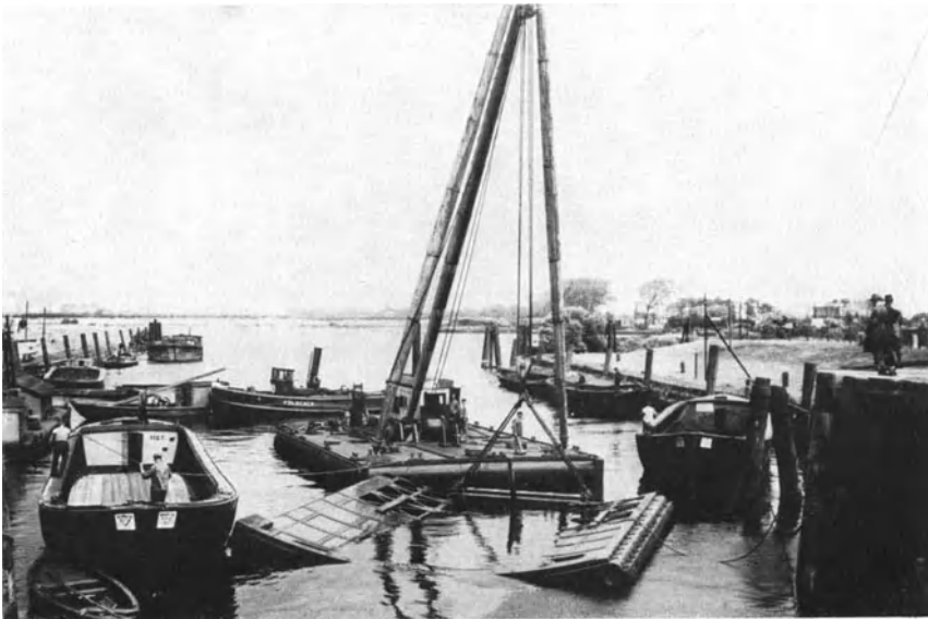
Abb. 104. Transport eines Schleusentores.
