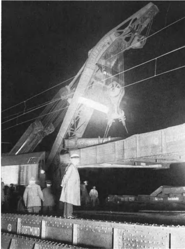
Abb. 69. Nächtliche Brückenauswechslung.
