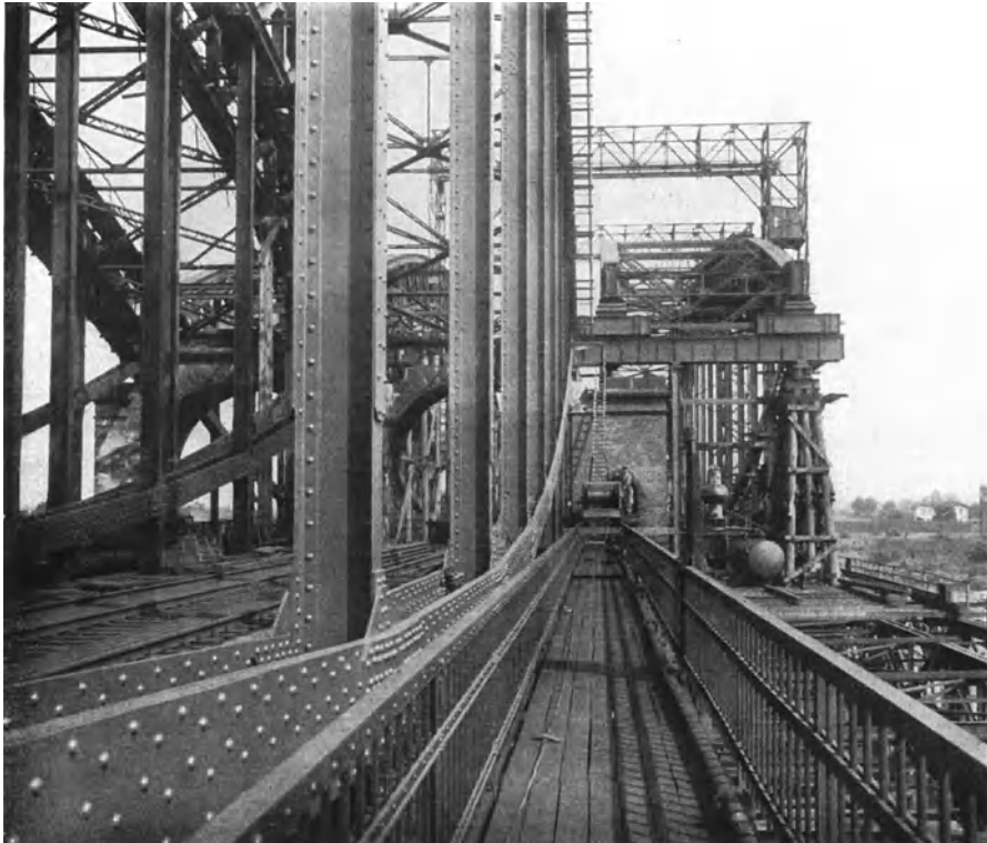
Abb. 31. Querverschieben einer Brücke.
