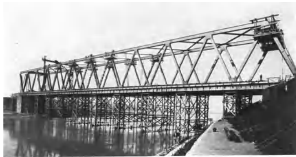
Abb. 14. Gerüst für eine Rheinbrücke.
