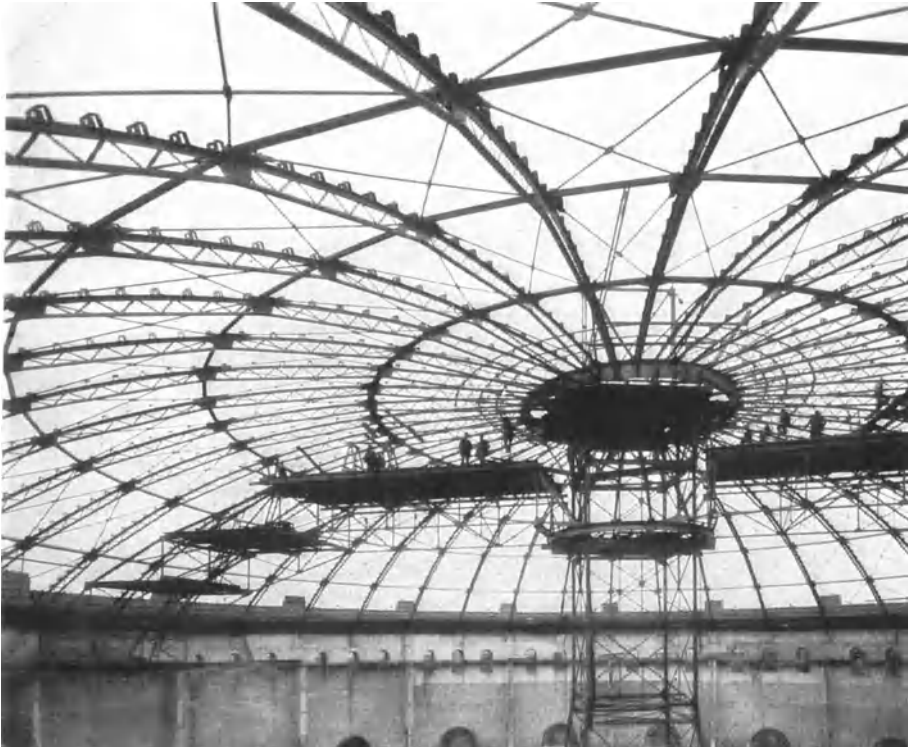
Abb. 80. Montage eines Kuppeldaches.
