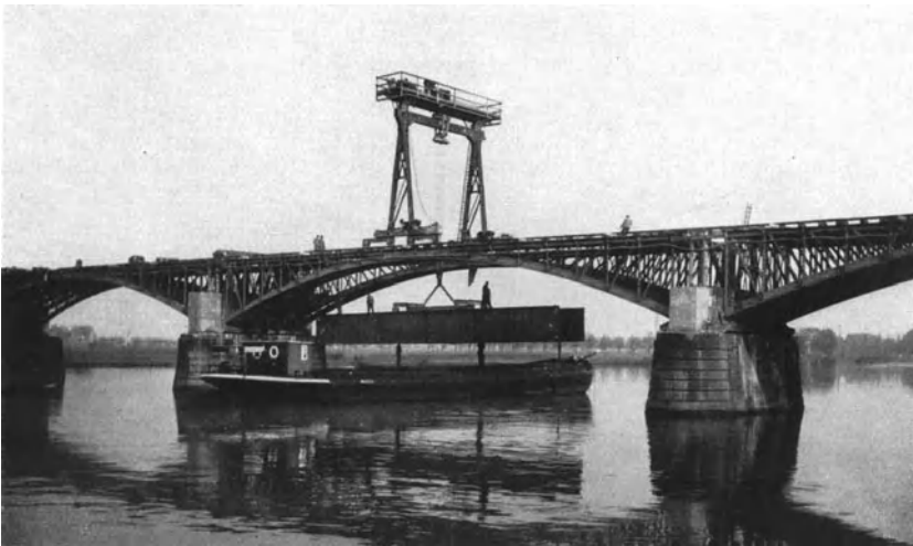
Abb. 56. Montage einer Blechträgerbrücke auf einer Bogenbrücke als Gerüst.
