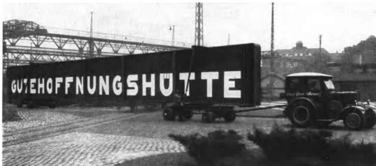
Abb. 51. Landtransport eines Blechträgers.
