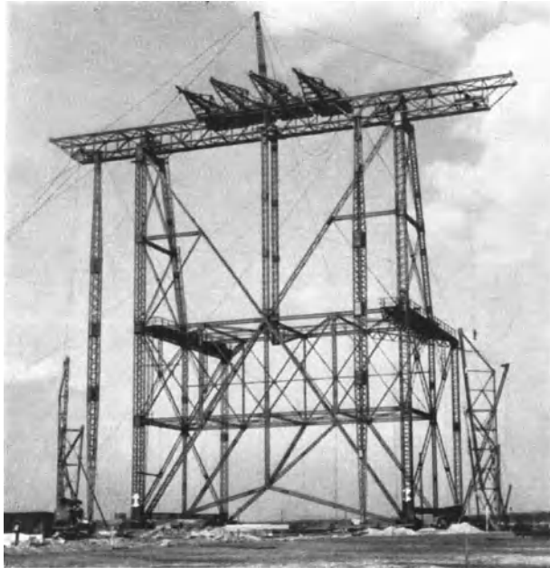
Abb. 79. Neuzeitliches Montagegerüst für eine Luftschiffhalle.
