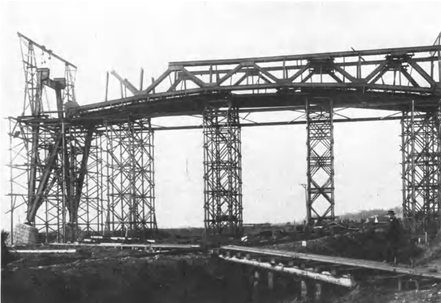
Abb. 15. Gerüst für ein hochliegendes Kreuzungsbauwerk.
