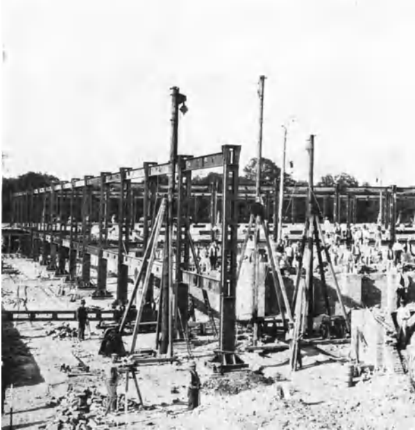
Abb. 70. Aufstellen eines Stahlskeletts.
