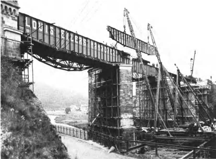
Abb. 55. Montage von Blechträgerbrücken mit Schwenkmasten.
