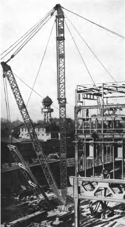
Abb. 94. Aufstellen einer Stütze.
