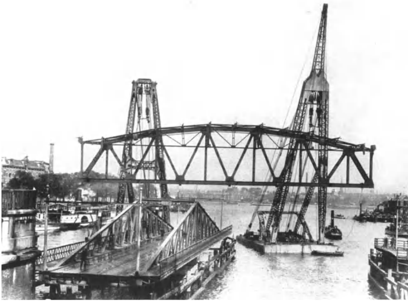
Abb. 39. Einlegen eines Hauptträgers mittels Schwimmkran.
