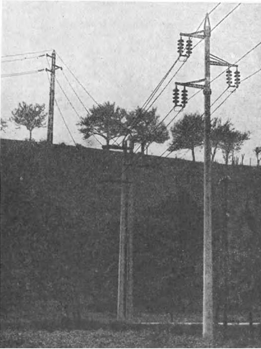
Abb. 112. Streckenabschnitt einer 60 kV-Drehstromleitung mit Eisenbeton-Schleudermasten, eisernen Isolatorträgern und Kettenisolatoren; Straßenkreuzung mit erhöhter Sicherheit.
