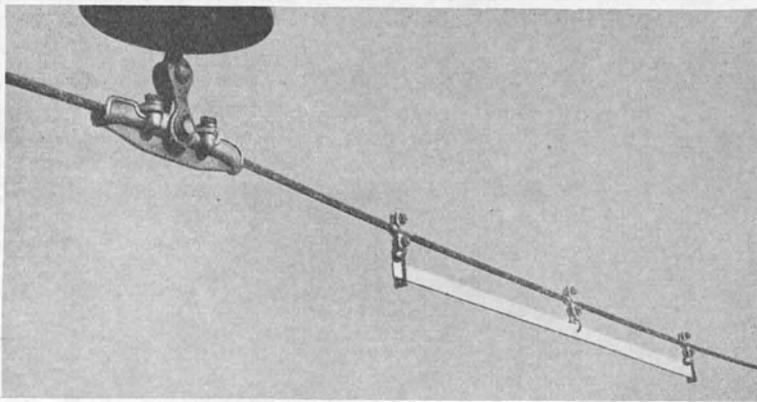
Abb. 275. Schwinghebeldämpfer zur Behebung der Seilschwingungen.
