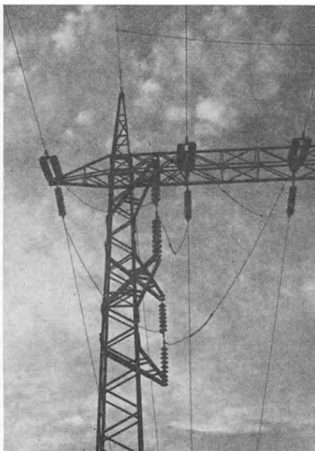
Abb. 266. Verdrillungsmast einer 100-kV-Drehstrom-Doppelleitung mit Portalmasten (A. G. Sächsische Werke).
