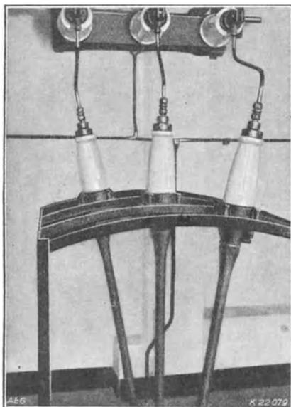
Abb. 376. Gabelgestell für Phasenwechsel zwischen Kabel und Innenleitung (AEG).
