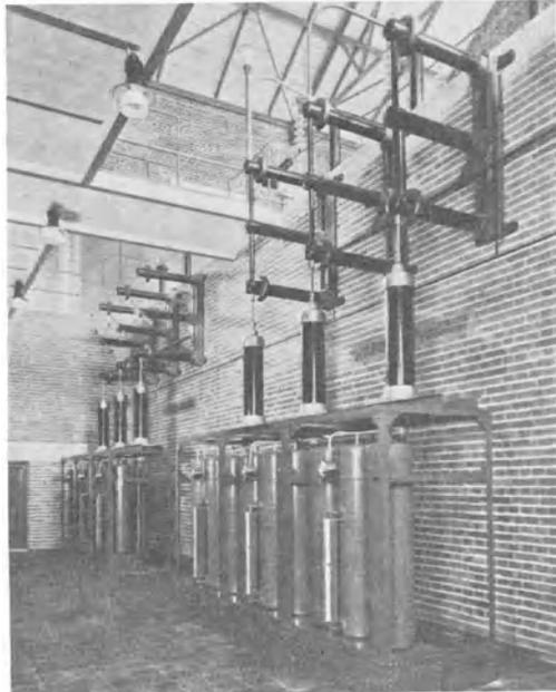
Abb. 380. Kabelendverschlüsse der 100 kV Einleiter-Ölkabel im Schalthaus Tullnau (SSW).
