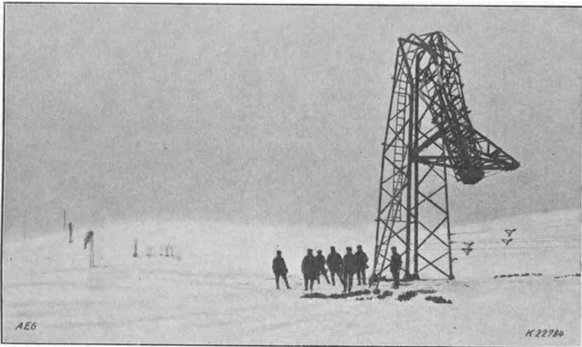
Abb. 129. Umgebrochene Hochspannungsleitung infolge Rauheisbelastung.
