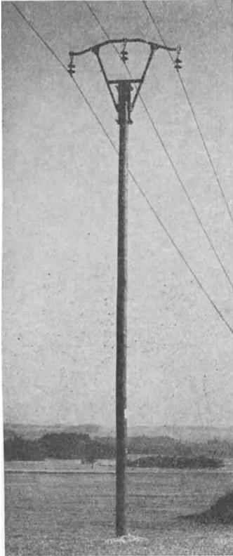
Abb. 215 a. Drehstromleitung 10 kV mit Holzmasten, Leiteranordnung siehe Zusammenstellung 38, Kleinkettenisolatoren.
