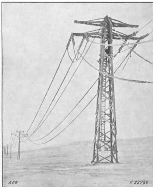
Abb. 128. Hochspannungsleitung mit Rauhreifbelastung.
