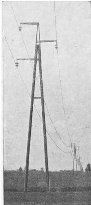
Abb. 215 b. Drehstromleitung 15 kV mit Holzmasten, Leiteranordnung siehe Zusammenstellung 38, Kleinkettenisolatoren.
