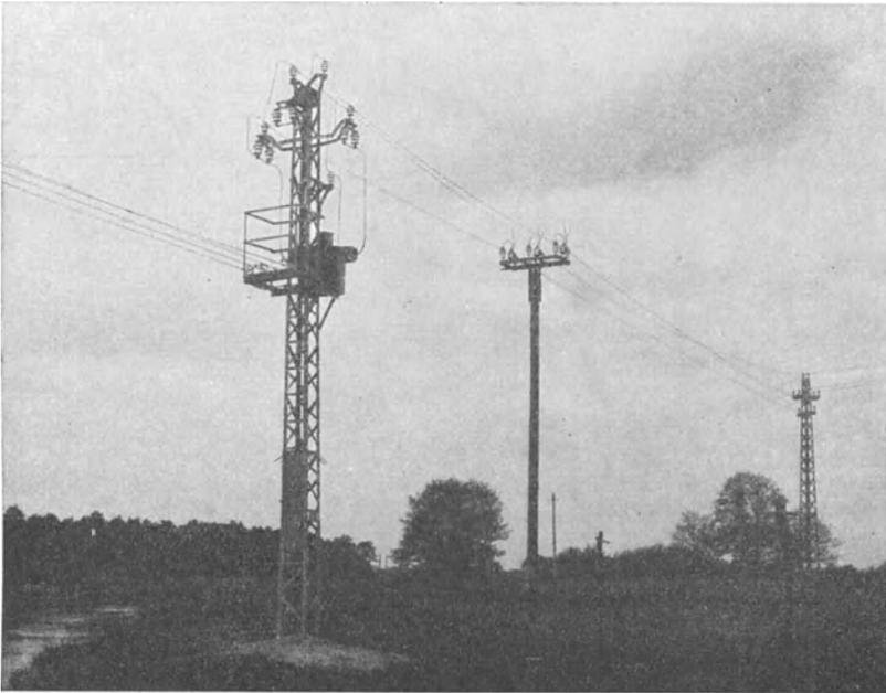
Abb. 109. Streckenabschnitt einer 15 kV-Leitung mit Abspannmast, Mastschalter und Masttransformator.
