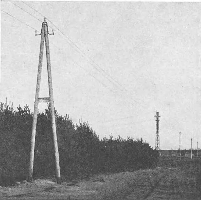
Abb. 108. Streckenabschnitt einer 15 kV-Drehstromleitung mit Holz- und Stahlgittermasten. Lyraträgern für die Stützenisolatoren, Spannweite im Mittel 80 m.
