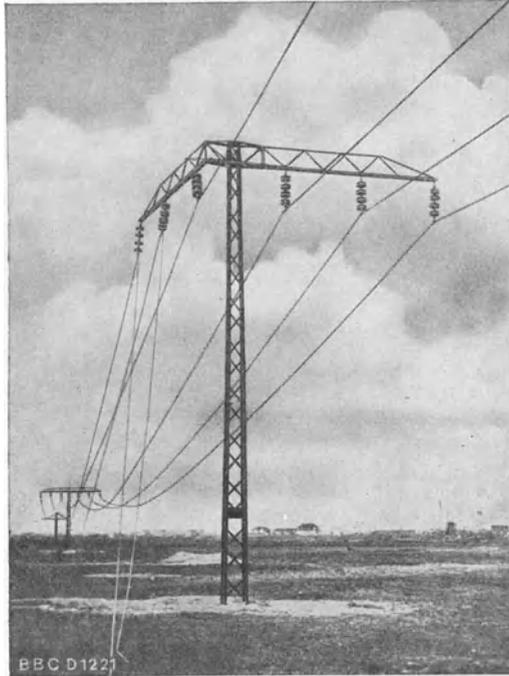
Abb. 232. Ausgeschwungene Traverse des Versuchsmastes Nr. 3 nach Durchschneiden von zwei Leiterseilen im Feld zwischen den Masten Nr. 3 und 4. Die Traverse des Versuchsmastes Nr. 2 (im Hintergrund) ist nur um etwa 25° ausgeschwungen.
