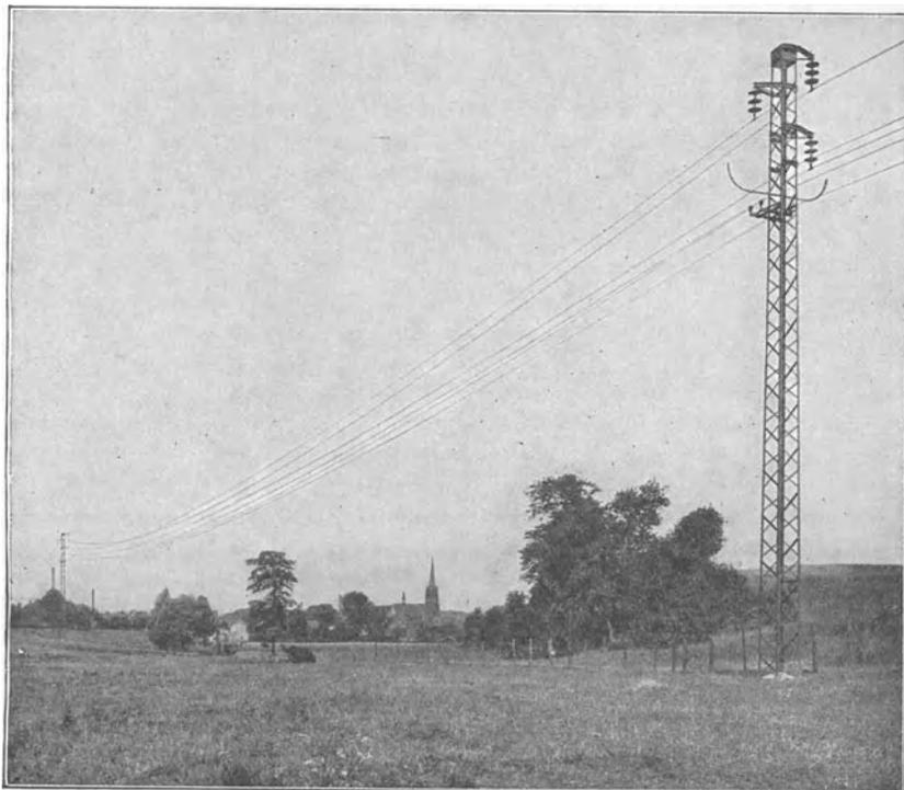
Abb. 287. Hochspannungsstrecke (Drehstrom, 30 kV, Kettenisolatoren) mit Betriebs-Fernsprechleitung.
