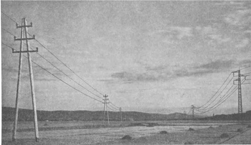
Abb. 110. Streckenabschnitt aus der Murgwerkanlage 100 und 20 kV-Leitungen auf getrennten Mastreihen.
