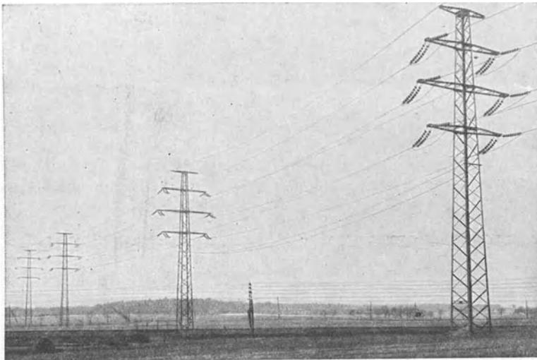
Abb. 111. Bruchsichere 100 kV-Kreuzung einer Staatsbahn und staatlicher Schwachstromleitungen (Prelldrähte, Erdseile).
