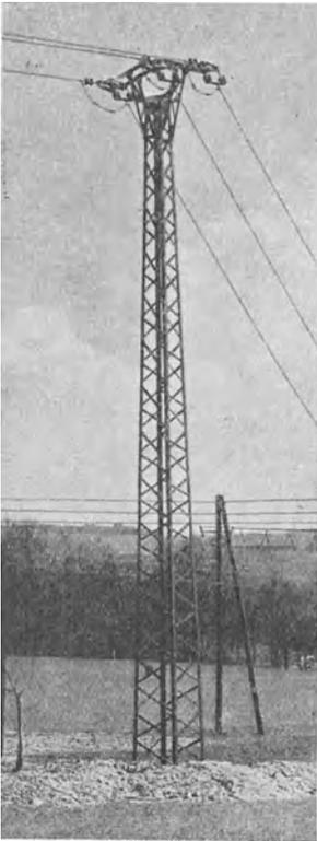
Abb. 223 a. 10 kV-Drehstrom-Einfachleitung, Abspannmast, ohne Erdseil. Quadratische Stahlgittermasten mit geschlossener Fundierung (Schwellenfundament).
