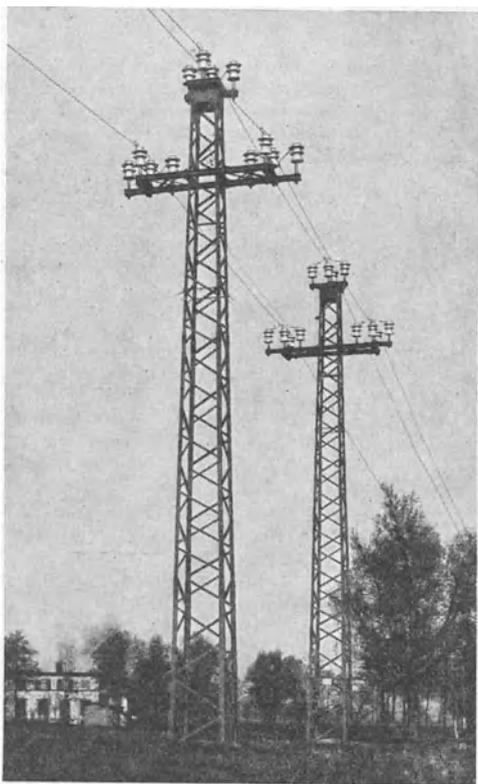
Abb. 271. Bruchsichere Straßenkreuzung einer 30-kV-Drehstromleitung.
