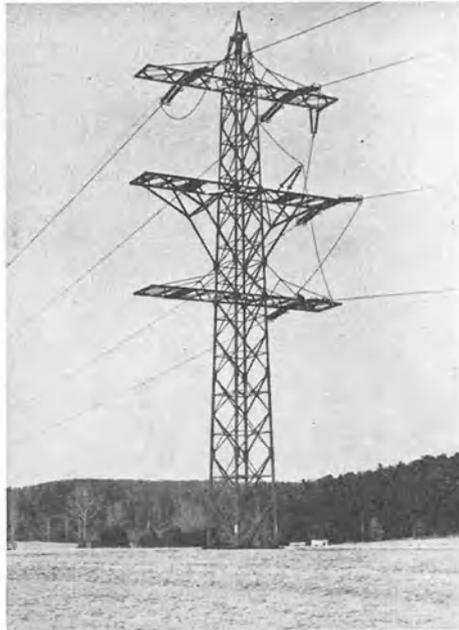
Abb. 265. Verdrillungsmast einer 220-kV-Drehstromleitung (Preußische Elektrizitäts A.-G.).
