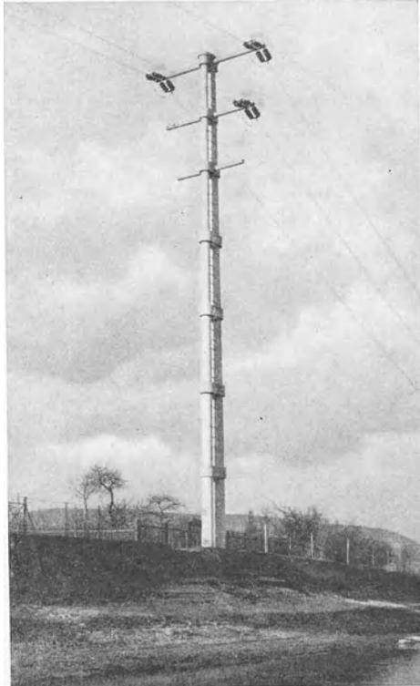
Abb. 240. Doppel-Eisenbeton-Schleudermast als Abspannmast für eine 50-kV-Drehstrom-Doppelleitung: ein Stromkreis aufgelegt.
