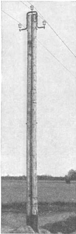
Abb. 202. Geschlossener Doppelholzmast.
