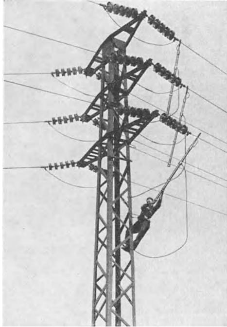
Abb. 279. Erdungs- und Kurzschlußstangen nach Abb. 278 im Betrieb.
