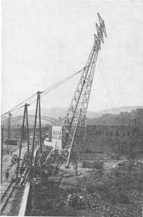
Abb. 236. Aufrichten eines 35 m hohen Stahlgitterturmes auf ein vorbereitetes Betonfundament.
