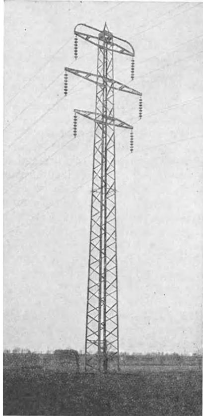
Abb. 223 b. 100 kV-Drehstrom-Doppelleitung, Tragmast, 2 Erdseile.
