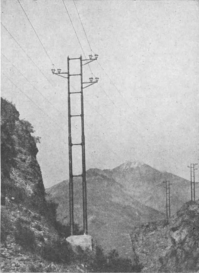
Abb. 218. Hochspannungsleitung mit Mannesmannröhren-Doppelmasten. Mastabstand 250 m, 6 Kupferdrähte von je 7 mm Durchmesser.
