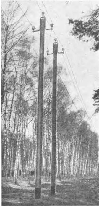
Abb. 264. Verdrillung einer 15-kV-Drehstromleitung auf Holzmasten.
