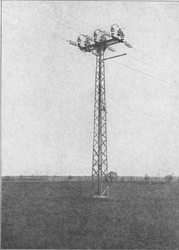
Abb. 255. Mastschalter für eine 40-kV-Drehstromleitung, Betätigung durch Stahlseil, Abspannung der Leiter an Kettenisolatoren (AEG).
