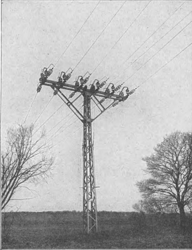
Abb. 256. Mastschalter für zwei 40-kV-Drehstromleitungen.
