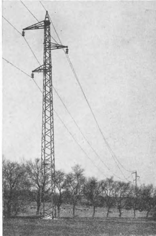
Abb. 230. Drehstromleitung 50 kV,  $3 \times 70 \text{ mm}^2 \text{ Cu}$ ,
