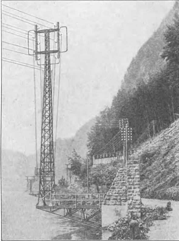
Abb. 237. Hochspannungsleitung an einer Bergstraße (Spannweite 120 m).
