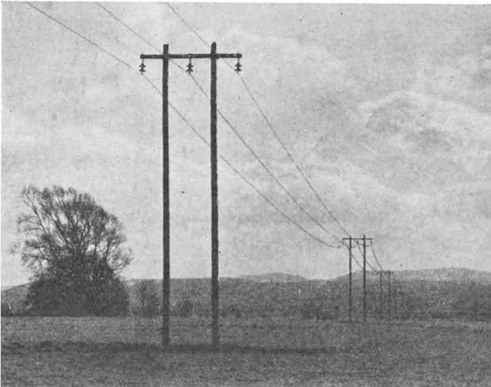
Abb. 216. Drehstromleitung 15 kV mit Holzmasten, Leiteranordnung siehe Zusammenstellung 38, Kleinkettenisolatoren.
