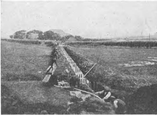
Abb. 357. Kabelgasse mit Holzpfählen durch eine Sumpfstrecke.
