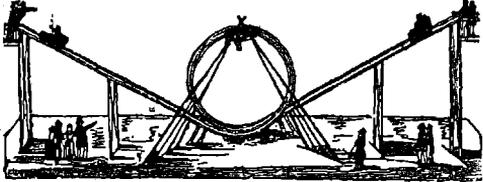
Вагонъ вѣсомъ въ 200 фунтовъ, съ сидящей въ немъ дамой или мужчиной, спускается по наклонной плоскости, объѣзжаетъ вокругъ вертикальной петли, высотой въ 40 футовъ, при чемъ голова пассажира обращается внизъ, а ноги вверхъ. Послѣ этого вагончикъ спускается съ колеса, поднимается на вторую наклонную плоскость и благополучно доставляетъ пассажира на мѣсто, пронося его со скоростью 100 миль въ часъ.
