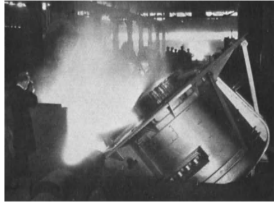
Fig. 4. Hochfrequenz-Induktionsofen für 5 t Fassung. (Werkphoto AEG.)
