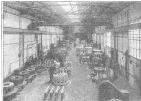
Bild 15. Beton-Reaktanzspulen-Bau.
