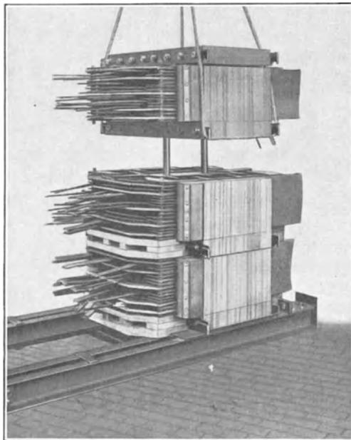
Bild 18. Aufbau eines Manteltransformators mit Kern aus E-Stücken.
