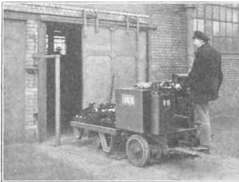
Bild 9. Pneumatischer Hallentoröffner.
