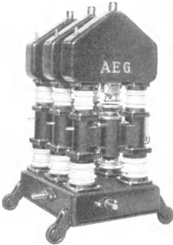
Bild 19. AEG-Wasserschalter für 10 kV.
