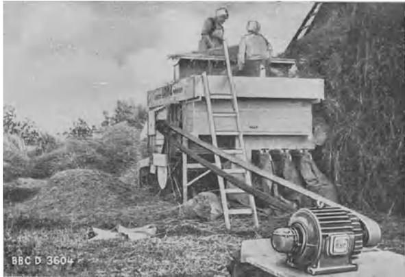
Abb. 45. Ortsbeweglicher Motor zum Antrieb einer Dreschmaschine.
