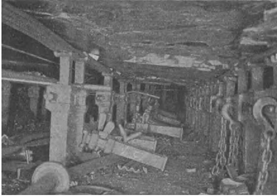
Abb. 54. Schwebende Anordnung der Reihenstempel an der Bruchkante.
