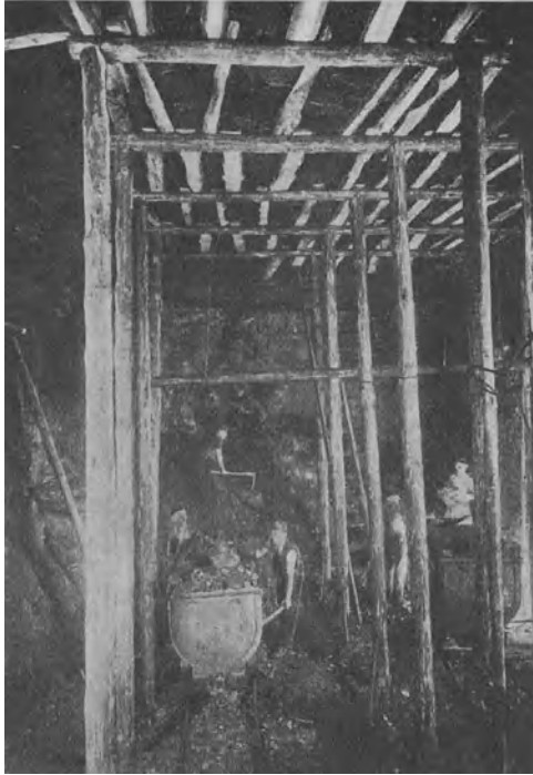
Abb. 56. Kappenausbau im Pfeilerbau. (Aufnahme M. S t e c k e l.)
