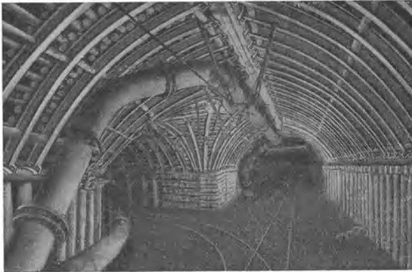
Abb. 129. Vieleckausbau mit Moll-Schalen in einer Gesteinsstrecke.
