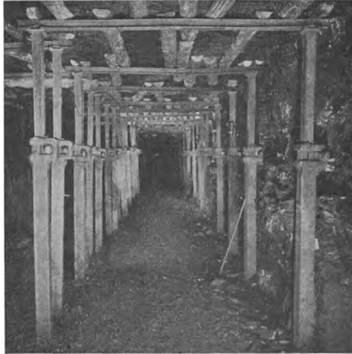
Abb. 47. Streichender Kappenausbau mit Stahlstempeln und Holzverzug.
