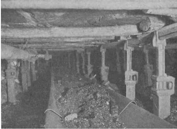
Abb. 49. Schwebender Kappenausbau mit Stahlstempeln und Holzverzug.
