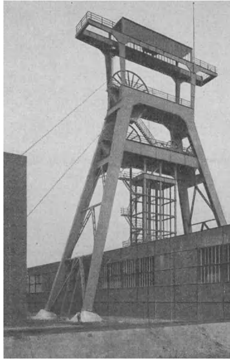
Abb. 646. Doppelbockgerüst mit übereinanderliegenden Seilscheiben.
