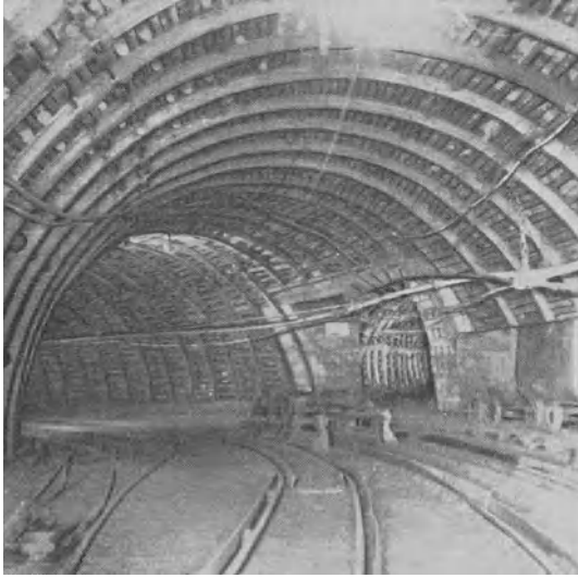
Abb. 127. Gesteinstrecke im Toussaint-Heintzmann-Ausbau.
