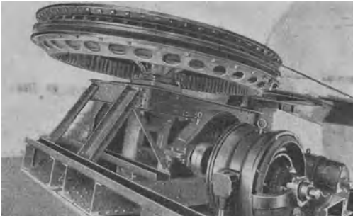
Abb. 500. Antriebsstelle einer liegenden Karlikscheibe.
