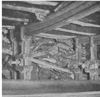
Abb. 53. Streichende Anordnung der Reihenstempel an der Bruchkante.
