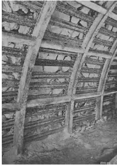
Abb. 135. Streckenstoß mit Stahlblech verzogen.
