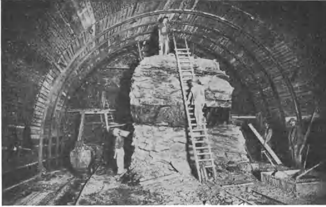
Abb. 158. Lehrgerüst aus Stahlprofilen für Ausmauerung eines Füllortes.
