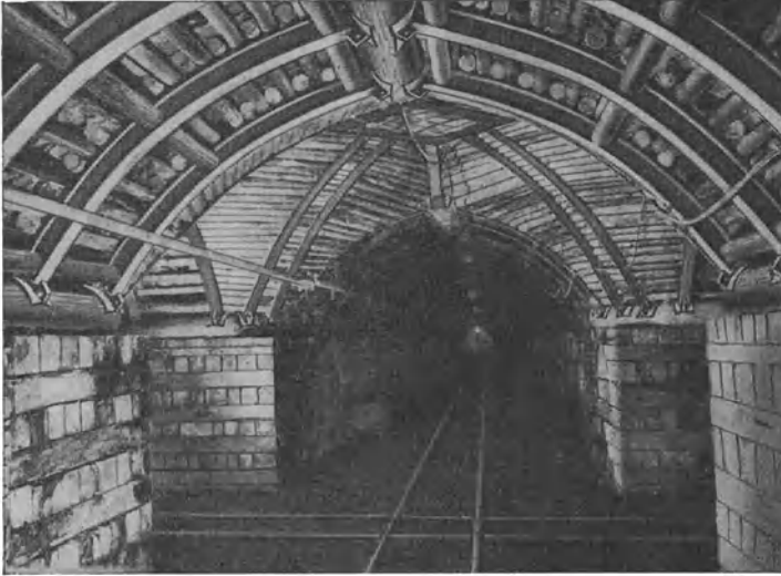
Abb. 139. Firstenkronen in einer rechtwinkligen Streckenkreuzung.
