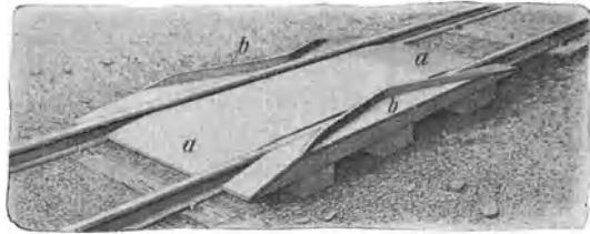
Abb. 468. Aufgleisplatte.
