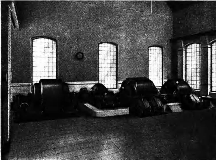
Abb. 31. BBC-Zweigehäuseturbokompressor mit Motorantrieb für 17500 m<sup>3</sup>/h Ansaugleistung.
