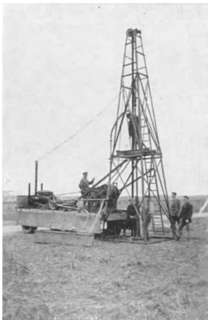
Abb. 74. Herstellung des Schußbohrloches.
