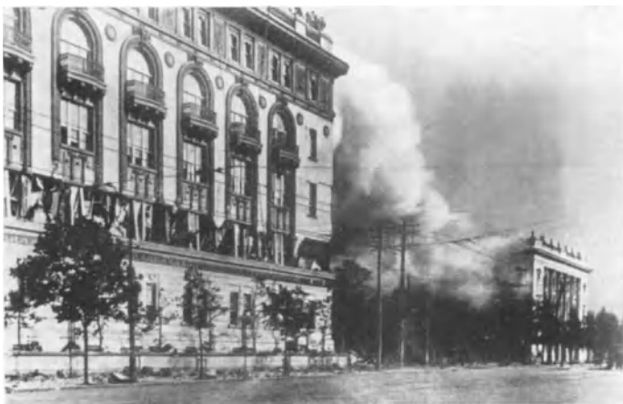
Abb. 12. Großes japanisches Beben vom 1. September 1923. Palast-Hotel, Tokio. Eisenskelettbau. Das Füllmauerwerk im zweiten Stockwerk hat den waagerechten Bebenstößen nicht standgehalten und ist herausgeplatzt. Die eisernen Säulen sind bis zu 30 cm verbogen, um einen entsprechenden Betrag hat sich der sonst unversehrt gebliebene obere Teil des Gebäudes gegen den unteren Teil verschoben. Im Hintergrund das brennende Kaiserliche Theater. 1 Stunde nach dem Erdbeben.
