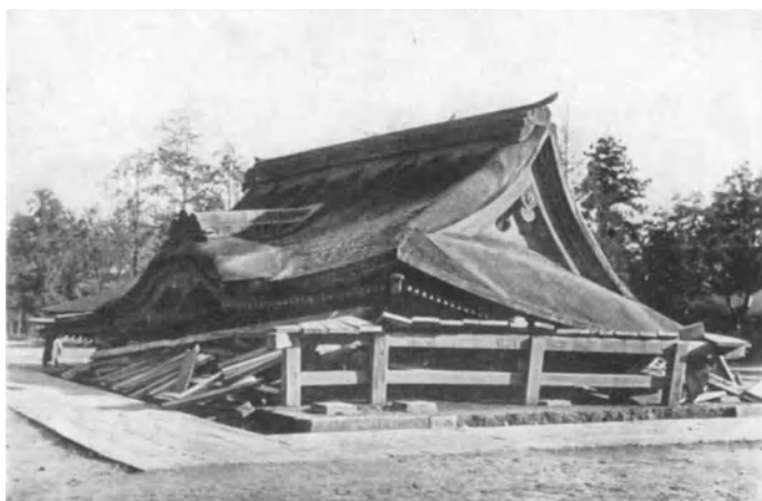
Abb. 13. Zerstörung eines Tempels. Zu schweres Dach. Großes japanisches Beben vom 1. September 1923.
