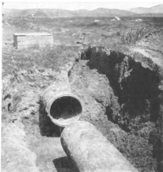
Abb. 8. Kalifornisches Beben vom 18. April 1906. Zerrissene Wasserleitung.
