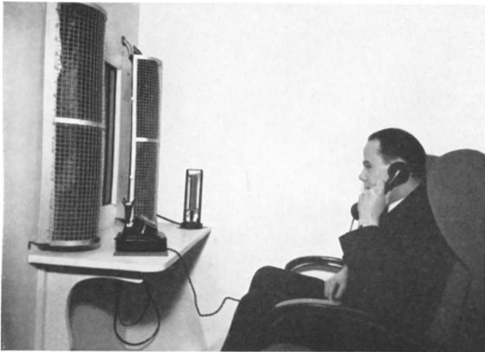
Abb. 14. Teilnehmerzelle für Fernsprechverkehr.
