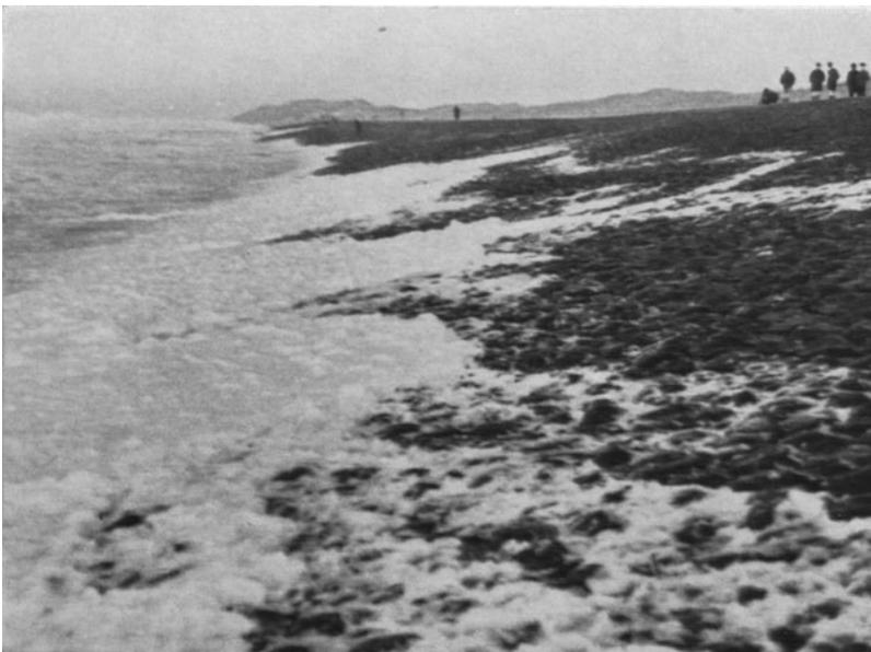
Abb. 16. Neues Deckwerk aus Basalt Neigung 1:4 am Ellenbogen.
