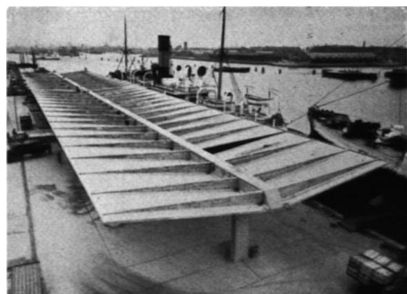
Abb. 28. 300 m lange Eisenbetondachüberdeckung der Kvaesthusbro im Bau.
