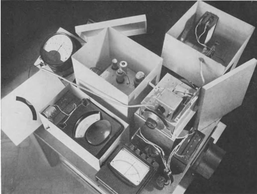
Abb. 76. Vorrichtung zur Bestimmung von Phasenwinkel und absoluter Größe der Steilheiten von Trioden, Tetroden, Pentoden, Hexoden, Heptoden und Oktoden im Kurzwellengebiet bis etwa 40 MHz.
