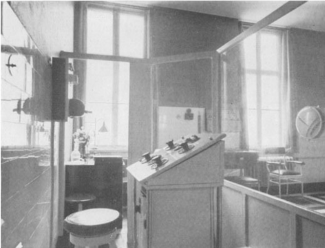
Abb. 4. Schaltraum, getrennt vom Bestrahlungsraum und Maschinenraum (HEDFELD).
