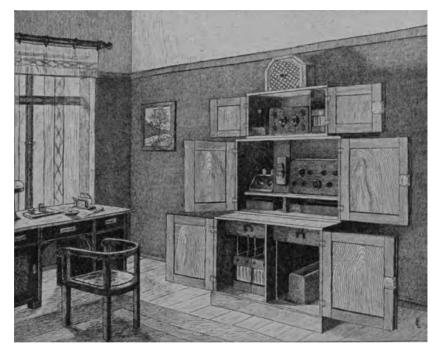
Abb. 113. Zentralstation der Großrundfunkanlage Abb. 112.
