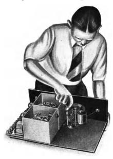
Abb. 73. Der Zusammenbau eines Fernempfängers aus geschirmten Einheiten.
