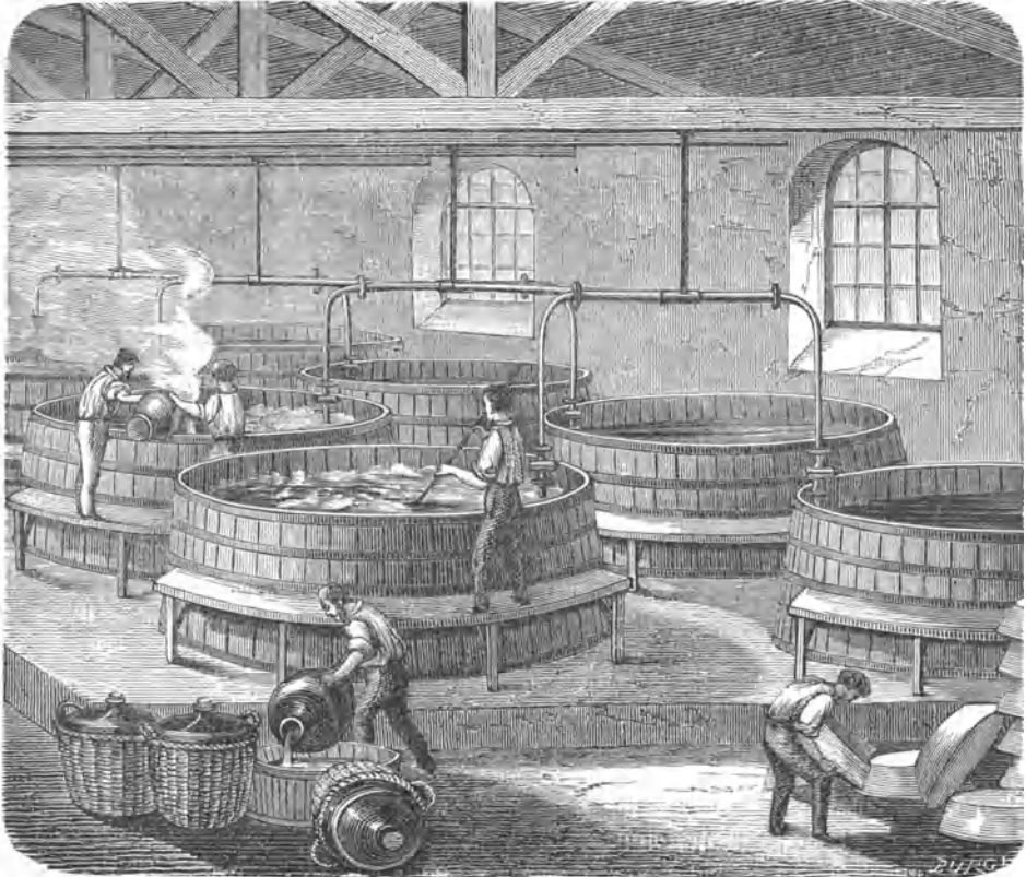
Fig. 213. Verseifen der Fette mit Kalk.
