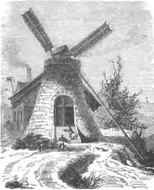
Fig. 37. Mühle zum Zerquetschen des Zuckerrohrs.
