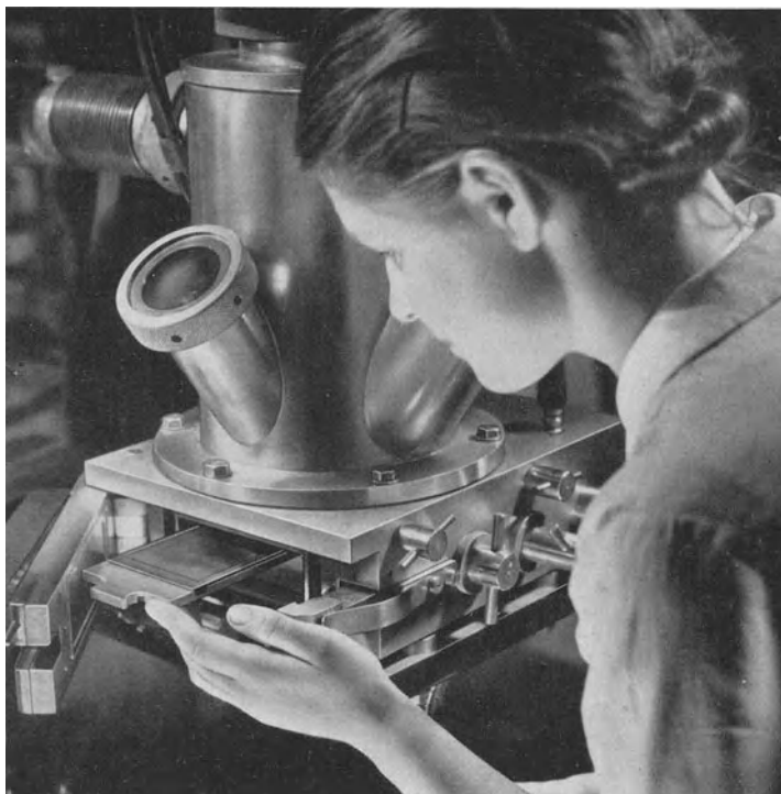
Abb. 175. Die Plattenschleuse des Siemens-Mikroskopes.
