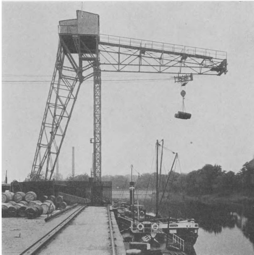
Abb. 677. Wasserseitige Stütze zum Kabelkran Abb. 676.
