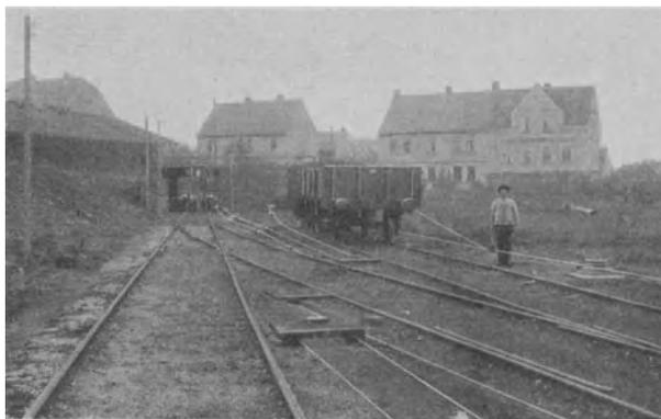
Abb. 483. Verschiebeanlage mit endlosem Seil (Arbeitsweise).
