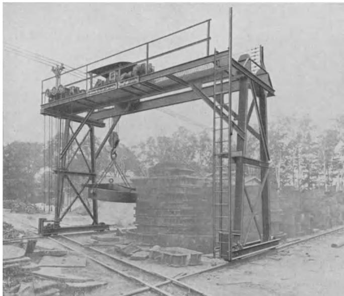
Abb. 647. Elektrisch betriebener fahrbarer Torkran (Bockkran) zur Bedienung eines Formkasten-Lagerplatzes. (Arbeitswerke.) Tragkraft: 5000 kg. Spannweite: 8 m.
