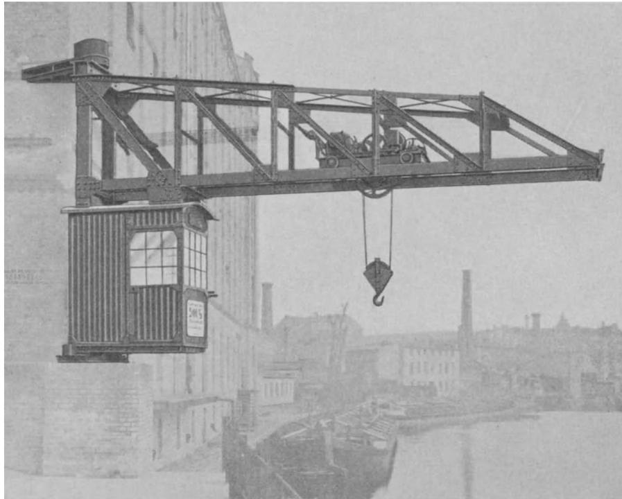
Abb. 765. Elektrisch betriebener Wanddrehkran von 5 t Tragkraft und 7,6 bzw. 1,6 m Ausladung. (Piechatzek.)
