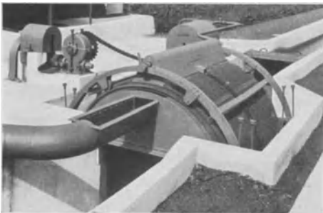
Abb. 26. GEIGERSches Trommelsieb (Kläranlage Essen-Rellinghausen).
