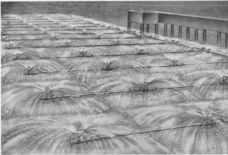
Abb. 132. Streudüsenanlage in Tätigkeit.
