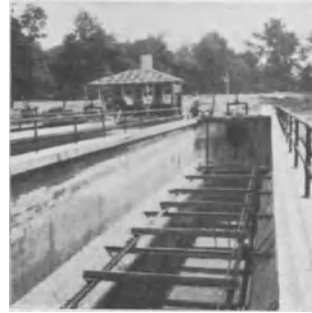
Abb. 64b. Ansicht eines leeren Link-Belt-Beckens.
