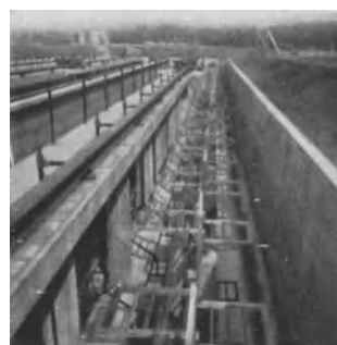
Abb. 159b. Belüftungsbecken mit Rührwerk und Zusatzluft. Bild.
