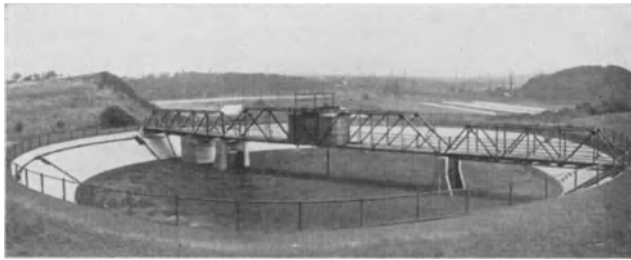
Abb. 84. Offener Faulraum der Kläranlage Witten.
