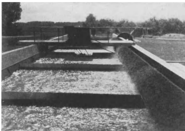
Abb. 149b. KESSENER-Verfahren in Betrieb.
