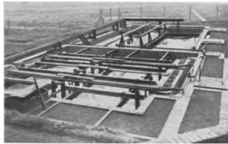
Abb. 62. Zweistufige Anlage für mit häuslichem Abwasser gemischte Phenolabwässer auf Zeche Mansfeld. Vorstufe belüftete Tauchkörper, Hauptstufe Schlammebelung.
