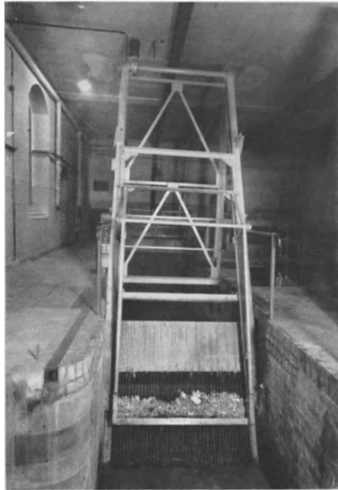
Abb. 24. Rechen mit Spindelantrieb System Dipl.-Ing. GEIGER Karlsruhe. (Kläranlage Buchenhofen bei Wuppertal und Essen-Rellinghausen.)
