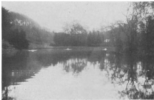
Abb. 126. Abwassereinfluß auf Pralltellern in den Abwasserfischteich der Kläranlage Holsterhausen.
