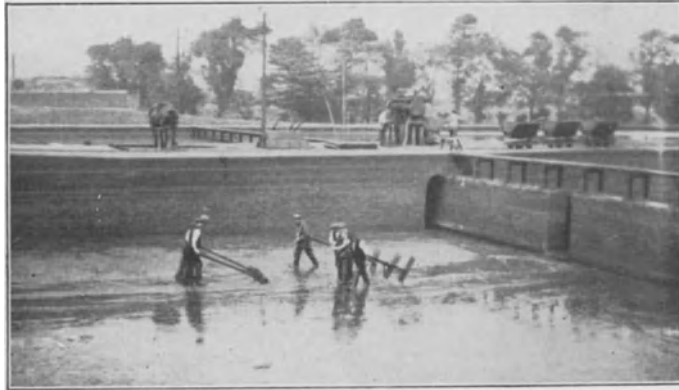
Abb. 47. Ausräumen eines flachen Absetzbeckens von Hand.
