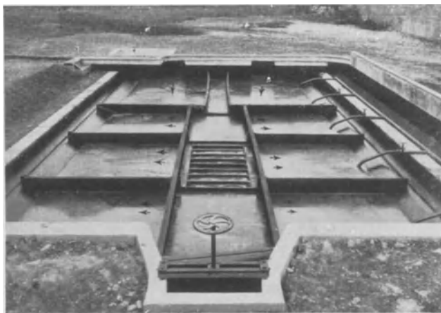
Abb. 36b. Bild des Mendener Ölfängers.
