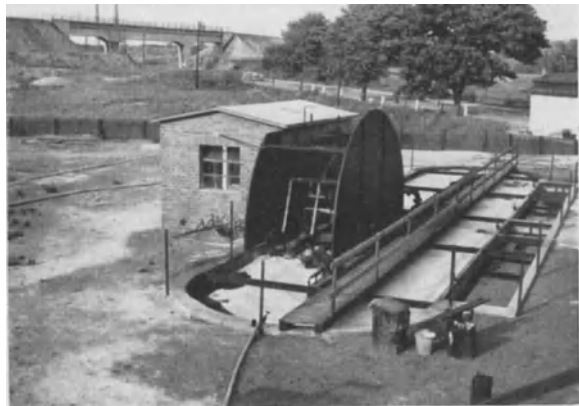
Abb. 164. Bild einer Anlage nach dem Magdeburger P-Verfahren zur Reinigung des Abwassers einer Margarinefabrik.
