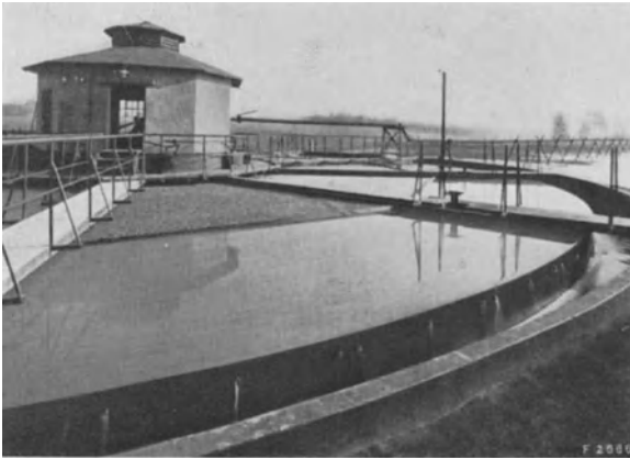
Abb. 29. Borsig-Mammut-Eindicker zum Klären der mechanisch verschmutzten Abwässer in einer Zuckerfabrik. Die Schwimmstoffe werden durch Auflegen hölzerner Balken abgefangen. (Werkphoto der Rheinmetall-Borsig-A.G. Berlin-Tegel.)
