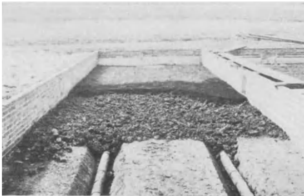
Abb. 43. Aufbau eines Sickerbeckens.
