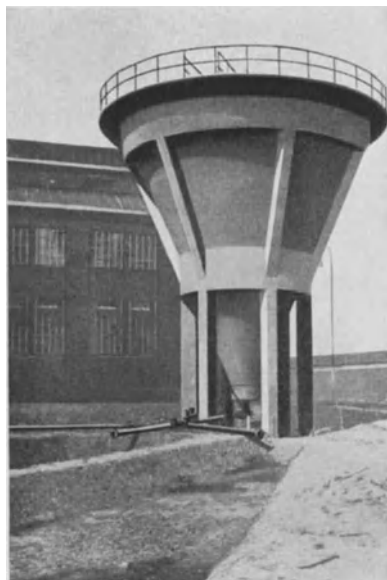
Abb. 73. Spitzklärurm für das Abwasser einer Spiegelglasschleiferei. Austrag des eingedickten Schlammes aus der Turmspitze durch den Wasserüberdruck. System Bamag-Meguini, Berlin.
