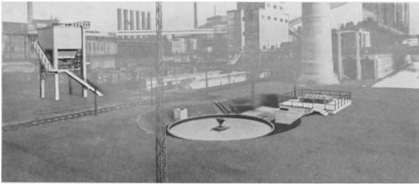
Abb. 53. Kläranlage für das Kokslöschwasser einer Kokerei System Bamag-Meguin. Schlammaustrag unter Wasser mittels eines drehbaren Schabers. Trocknung der Kokslösche in einem hochstehenden Eindickbehälter.
