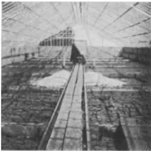
Abb. 105. Glasüberdeckter Schlamm-trockenplatz.
