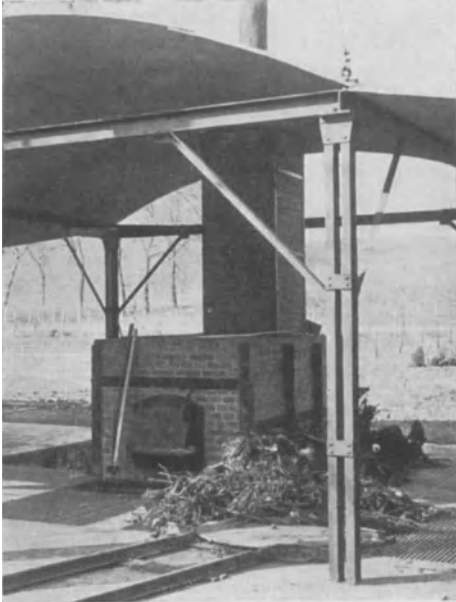
Abb. 32. Verbrennungsofen für Rechengut (Kläranlage Essen-Rellinghausen).
