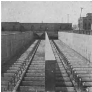
Abb. 156a und b. Schema (a) und Bild (b) der Druckluftbelüftung durch Filter an der tiefsten Stelle des trichterförmig aufgelösten Bodens. Furchenbecken der Kläranlage Milwaukee.
