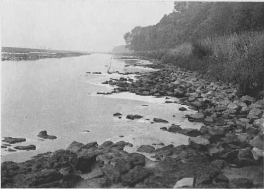
Abb. 6. Starke Ölverschmutzung eines zur Trink- und Brauchwasserförderung benutzten Flusses durch ein industrielles Werk.
