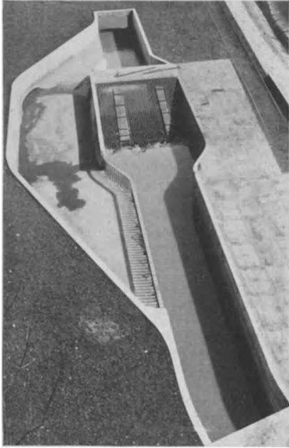
Abb. 22a. Bild eines handbedienten Grobrechens der Kläranlage Essen-Rellinghausen.
