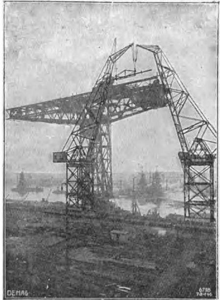
Montage eines Hammerkranes mit Hilfe zweier fahrbarer Turmdrehkrane. (Demag.)
