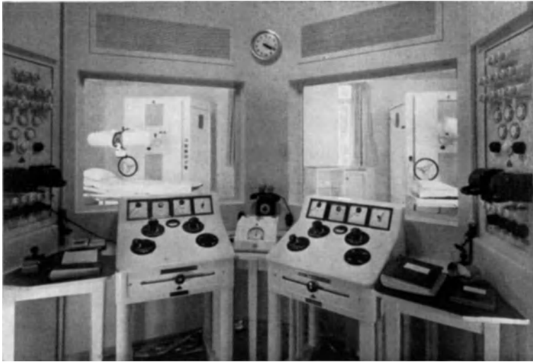
Abb. 35. Schalraum mit Durchblick in die beiden Rontgenbestrahlungsraume.
