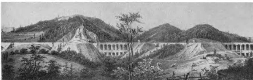
Abb. 16. Semmeringbahn, Gamperlgraben und Wagnergraben.
