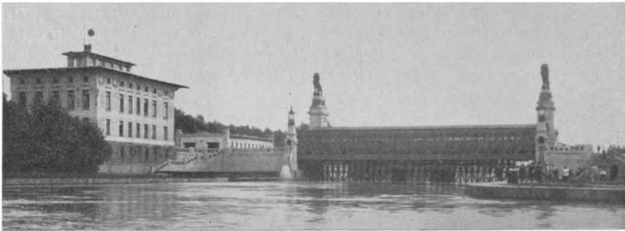
Abb. 5. Die Schleuse des Donaukanals in Nußdorf bei Wien.
