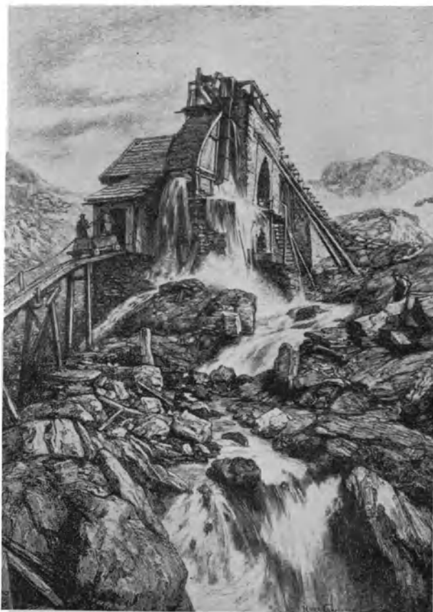
Abb. 7. Förderanlage am Goldberg in Rauris, Salzburg.
