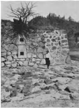
Abb. 2. Kaimauer an der Mündung mit Öffnungen zur Anbringung eines schwimmenden Rechens.
