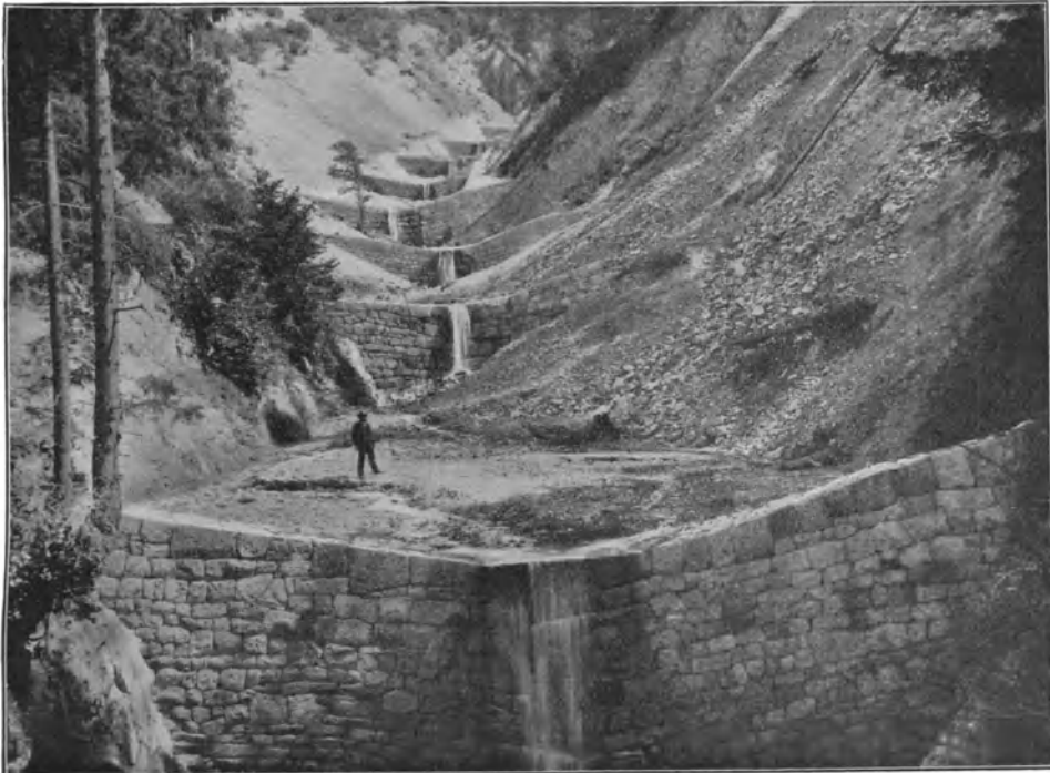
Abb. 3. Gödnacher Bach, Osttirol, Abtreppung mittels trocken gemauerter Sperren, Bruchflächen noch nicht begrünt.
