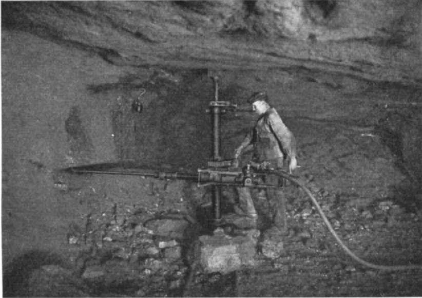
Abb. 52. Säulenschrämmaschine, Ausführungsform der Demag.
