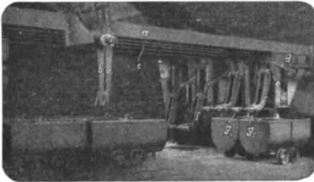
Abb. 357. Aufschiebevorrichtung der Maschinenfabrik Hasenclever A.-G.
