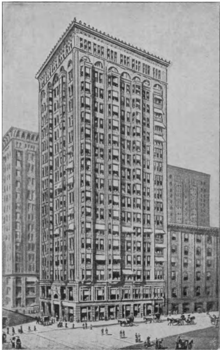
Fig. 4. Das Fisher-Gebäude, Chicago.
